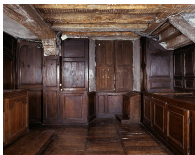
Vue des placards du fond de la sacristie avec les vantaux des fenêtres. Phot. Laurent Jumel IVR22_19966001797XA
