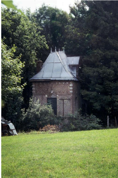
Vue générale. Phot. Christiane Riboulleau IVR22_20030200128ZA
