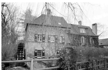
Le moulin : façade antérieure. Phot. Bertrand Fournier IVR22_20006000163Z
