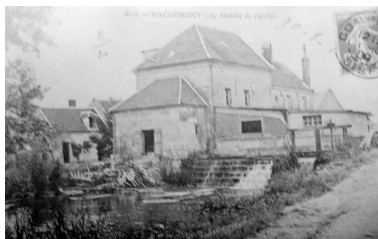
Vue du moulin encore pourvu du bâtiment abritant la roue hydraulique à gauche, vers 1905 (AP). Phot. Bertrand Fournier IVR22_20006000162ZB
