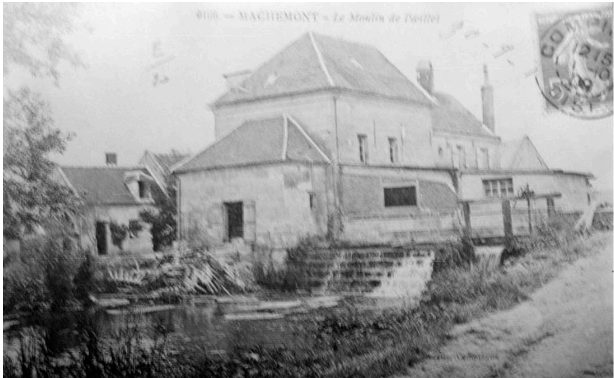
Vue du moulin encore pourvu du bâtiment abritant la roue hydraulique à gauche, vers 1905 (AP).
