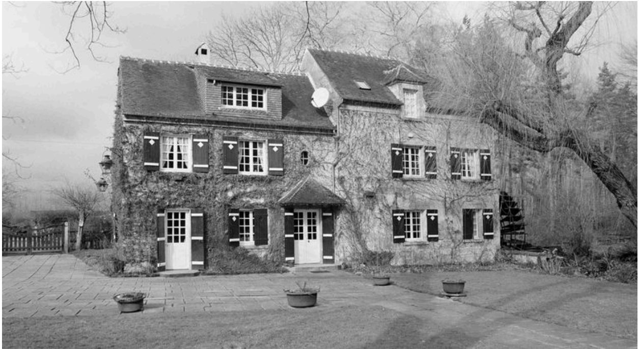
Vue générale du moulin : façade postérieure.
