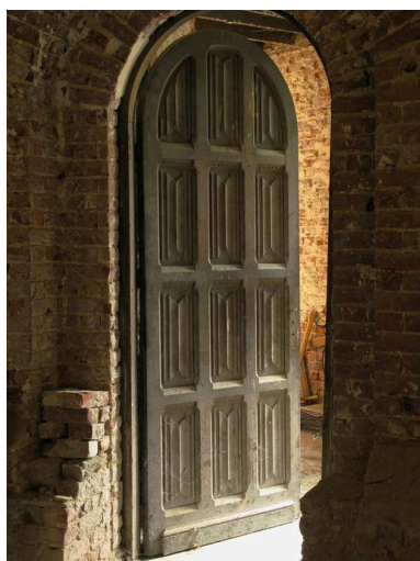
Porte de la sacristie Phot. Bruno Decrock IVR31_20126201580NUCA
