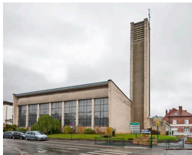
Vue générale. Phot. Pierre Thibaut IVR31_20106201713NUCA
