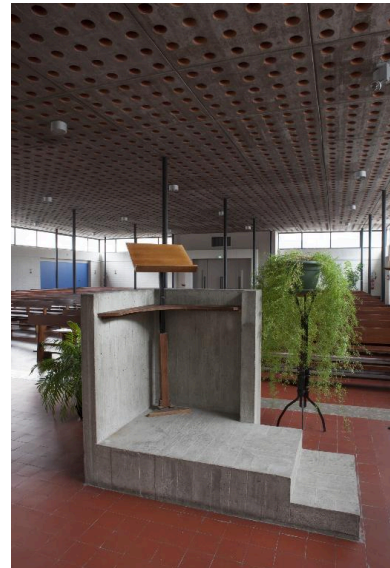
Vue arrière de la chaire à prêcher. Phot. Pierre Thibaut IVR31_20155900201NUCA
