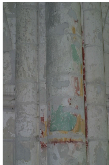
Restes de polychromie sur un pilier de la nef. Phot. Inès Guérin IVR22_20030202418NUCA
