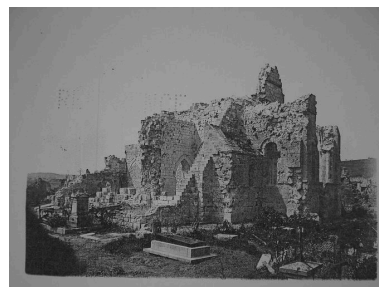
Vue de l'église en ruines en 1921 (DRAC Picardie, M.H. : 60090). Phot. Inès Guérin IVR22_20030203074NUCAB
