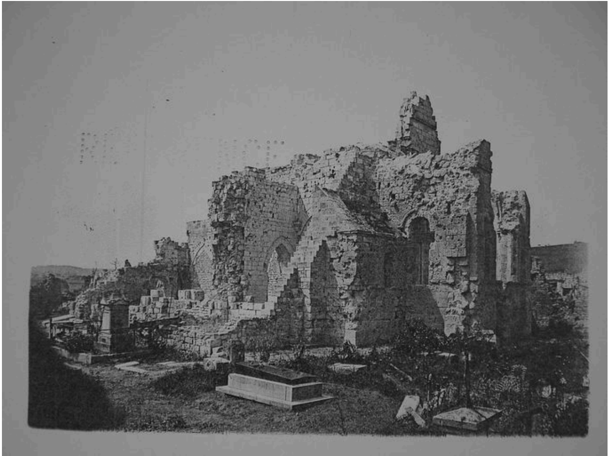
Vue de l'église en ruines en 1921 (DRAC Picardie, M.H. : 60090).
