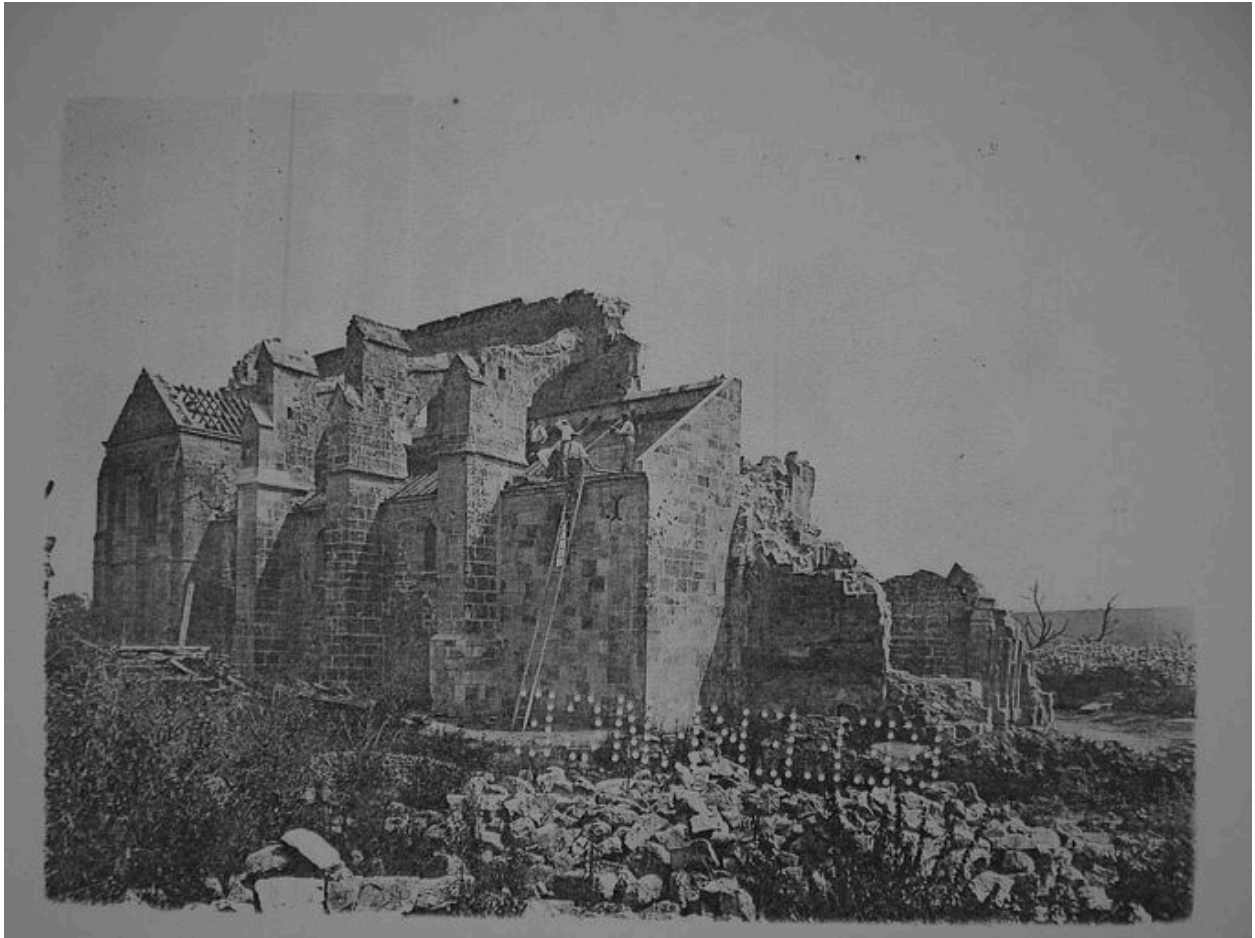
Vue de l'église en ruines en 1921 depuis le nord-ouest (DRAC Picardie, M.H. : 60091).
