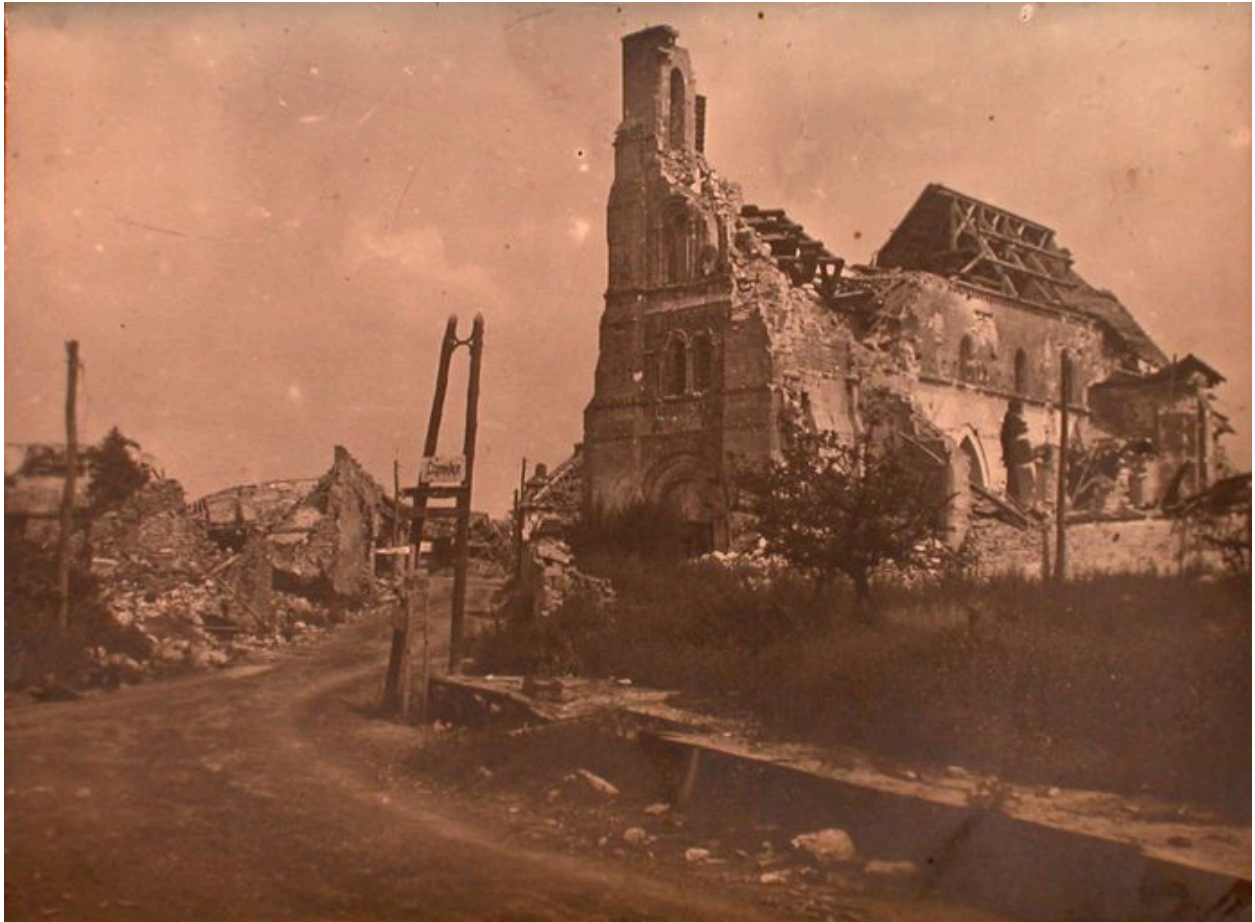
Vue de l'église en ruines (AD Aisne : 2 Fi Colligis-Crandelain 3).
