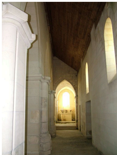
Vue du collatéral nord. Phot. Inès Guérin IVR22_20030202424NUCA
