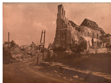
Vue de l'église en ruines (AD Aisne : 2 Fi Colligis-Crandelain 3). Phot. Inès Guérin IVR22_20030202394NUCAB
