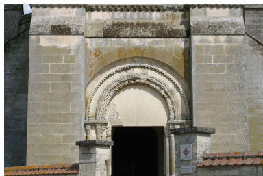
Vue du portail d'entrée. Phot. Inès Guérin IVR22_20030202405NUCA
