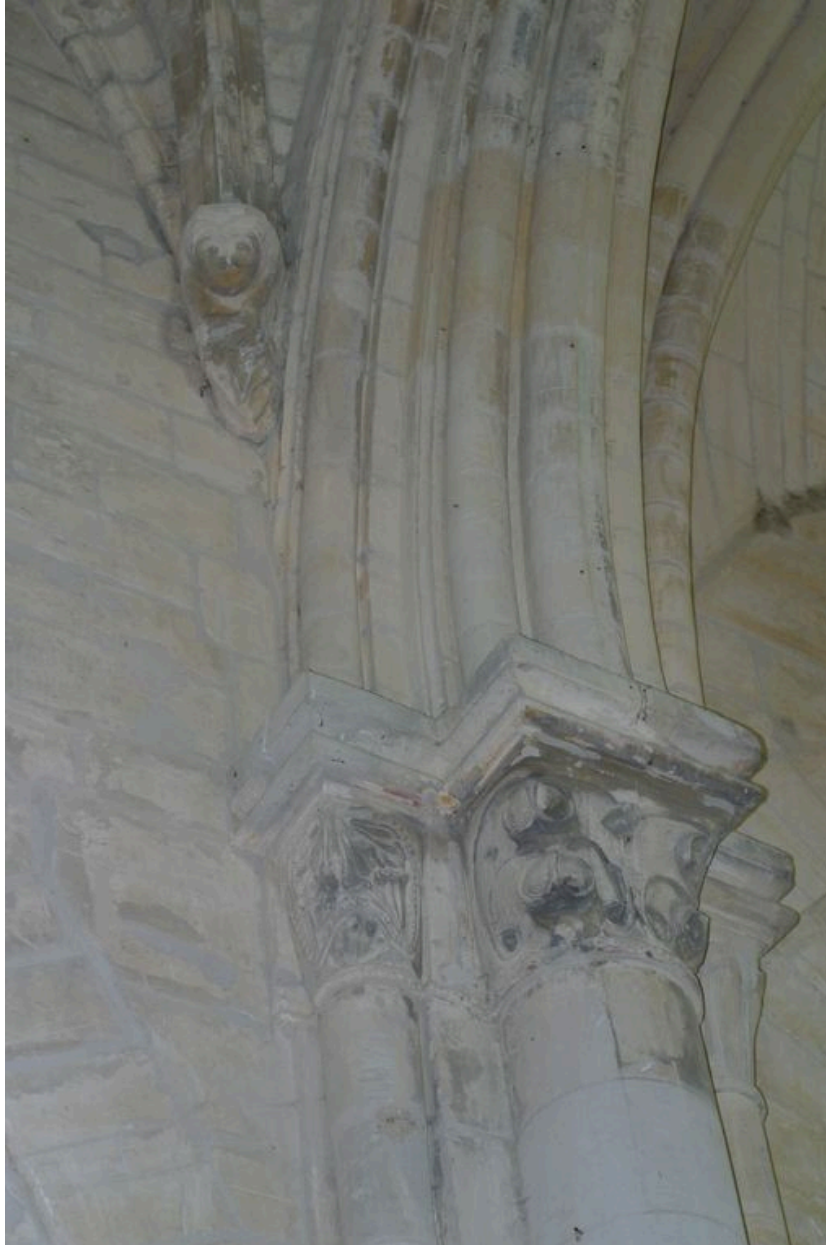
Vue des chapiteaux et naissances des ogives de la nef.
