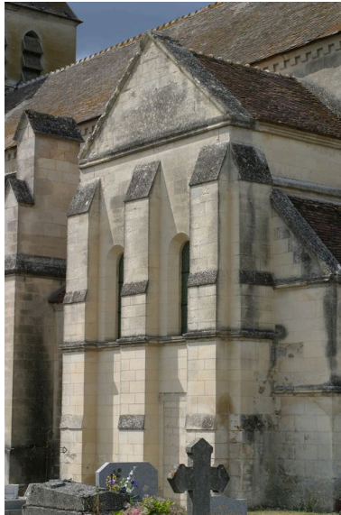
Vue du croisillon sud. Phot. Inès Guérin IVR22_20030202413NUCA
