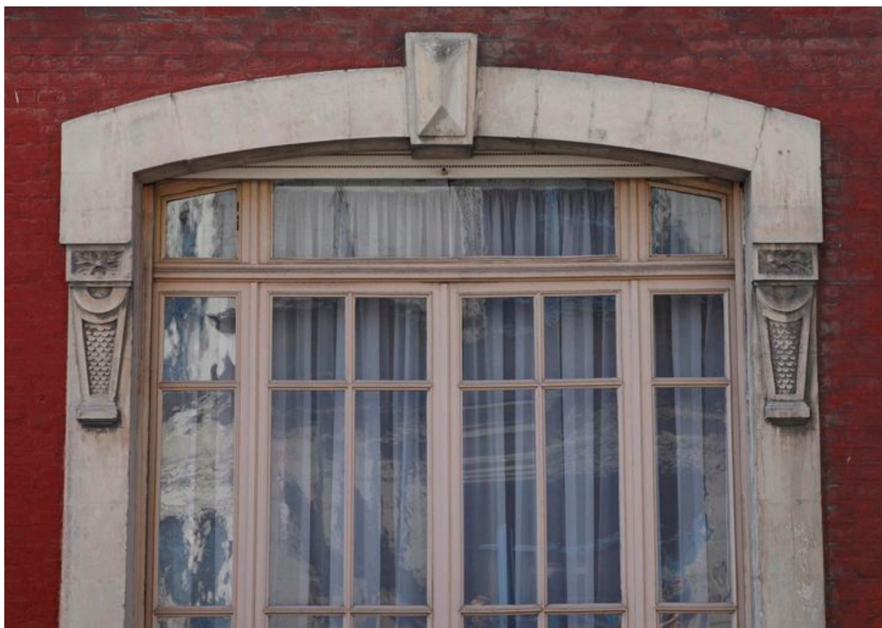
Vue sur l'encadrement sculpté d'une baie située au rez-de-chaussée.
