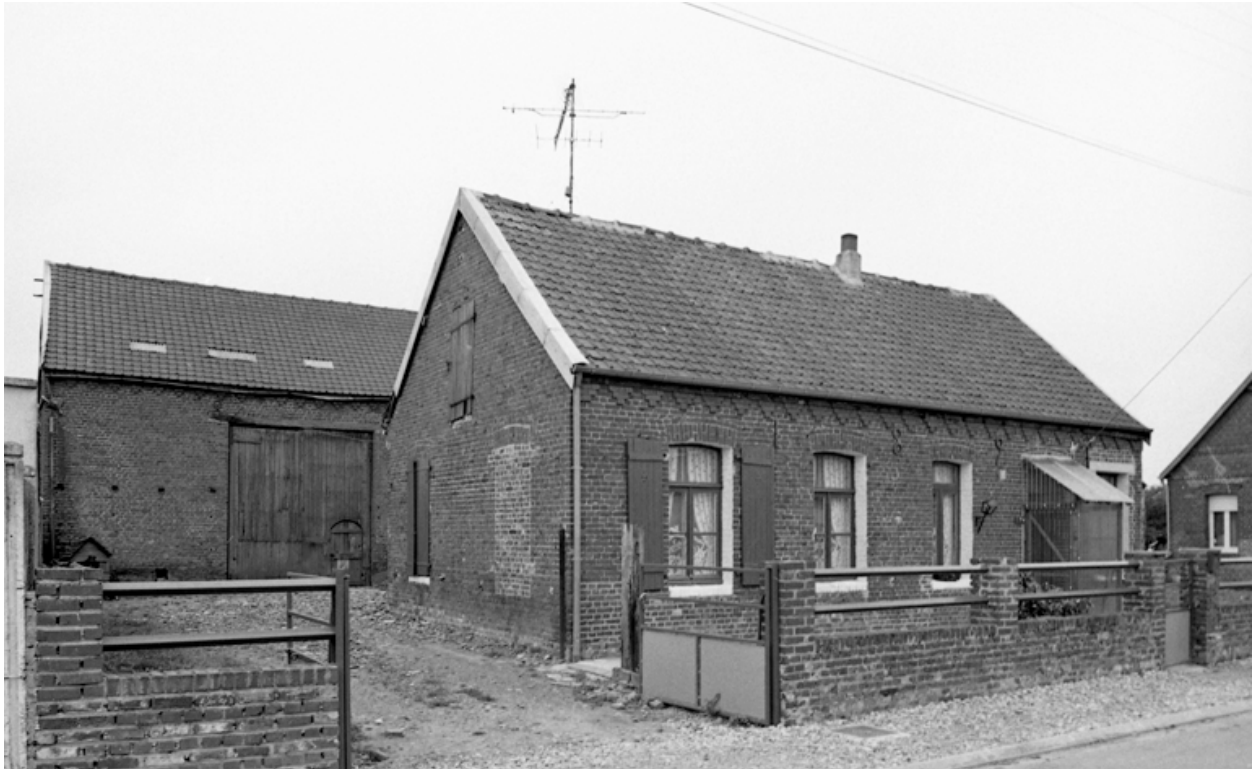
Vue d'ensemble du logis et de la grange depuis le nord-est.
