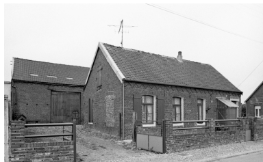
Vue d'ensemble du logis et de la grange depuis le nord-est. Phot. Thierry Lefébure IVR22_19920201300Z
