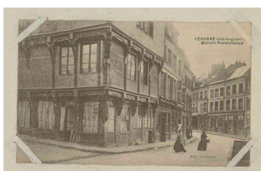
Péronne (avant-guerre). Maison Renaissance. Photographie, avant 1914 (AD Somme ; 10R 1019). Phot. Archives départementales de la Somme IVR32_20218005228NUCA
