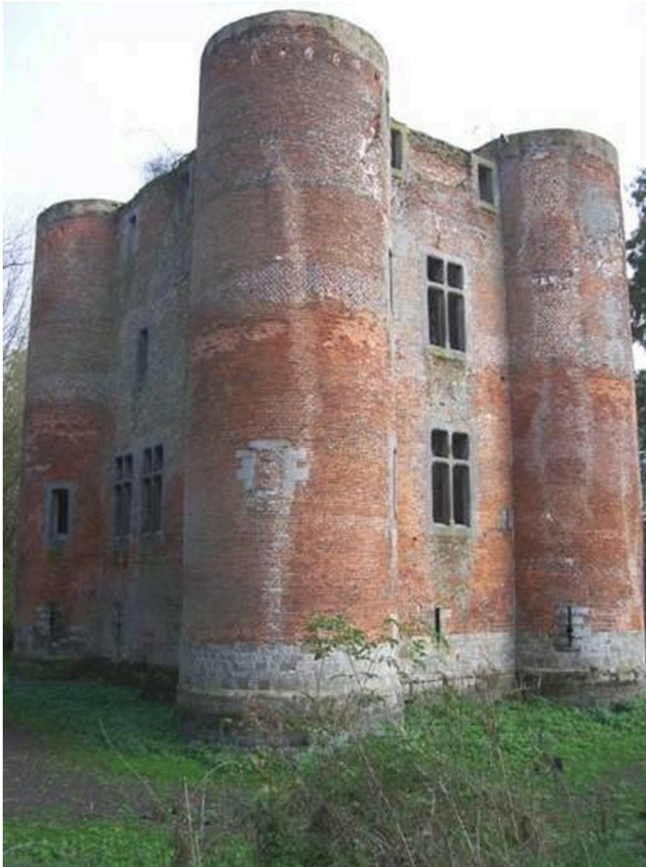
Vue générale des élévations nord et ouest.
