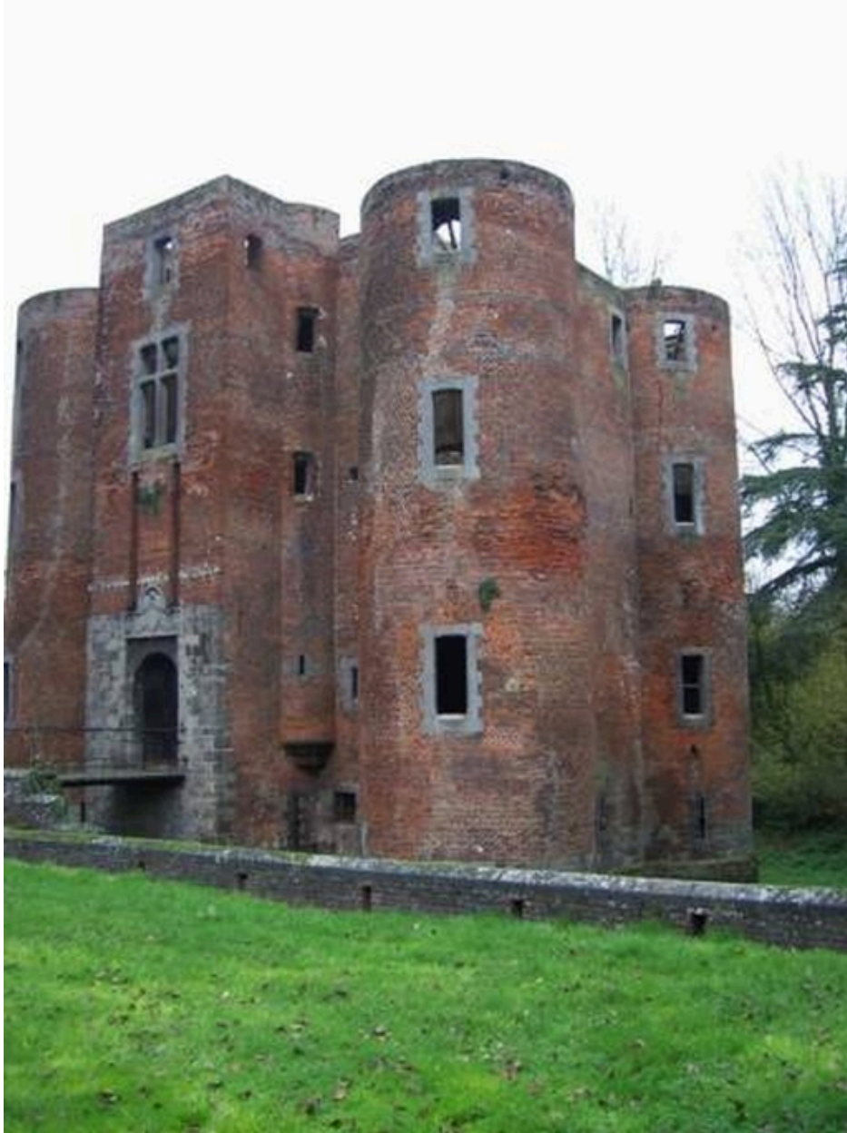
Vue générale, façades sud et est.
