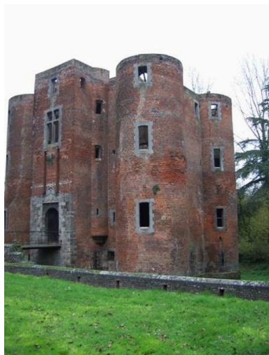
Vue générale, façades sud et est. Phot. Cyril Cailleau IVR31_20055907296NUCA
