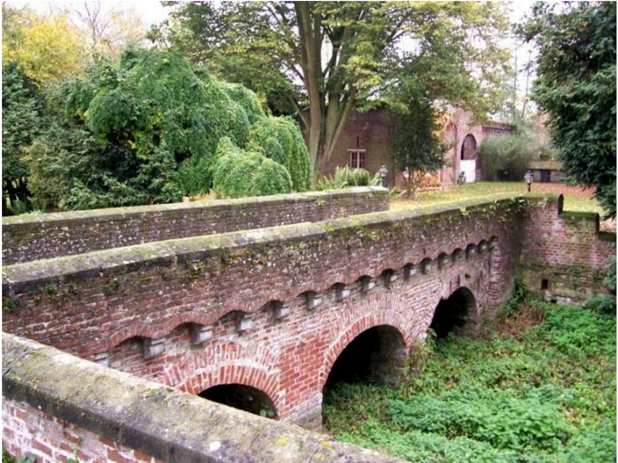
Le pont permettant l'accès à la seconde enceinte.
