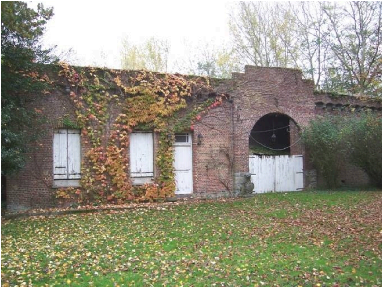
Vue générale des communs.
