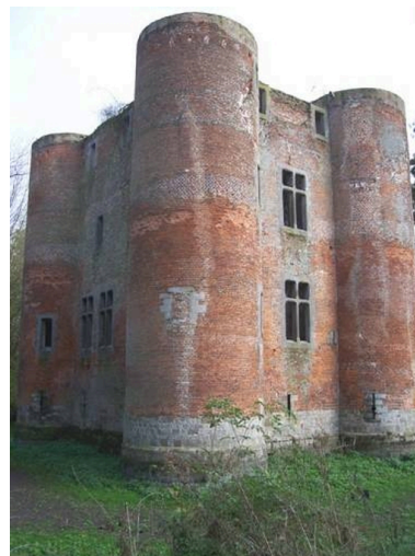
Vue générale des élévations nord et ouest. Phot. Cyril Cailleau IVR31_20055907298NUCA
