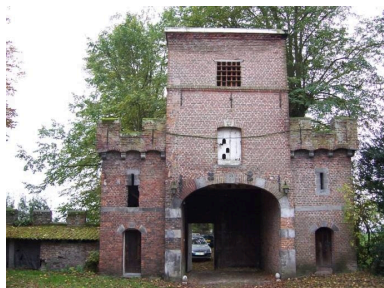
Vue générale du porche- colombier, élévation sur cour. Phot. Cyril Cailleau IVR31_20055907293NUCA
