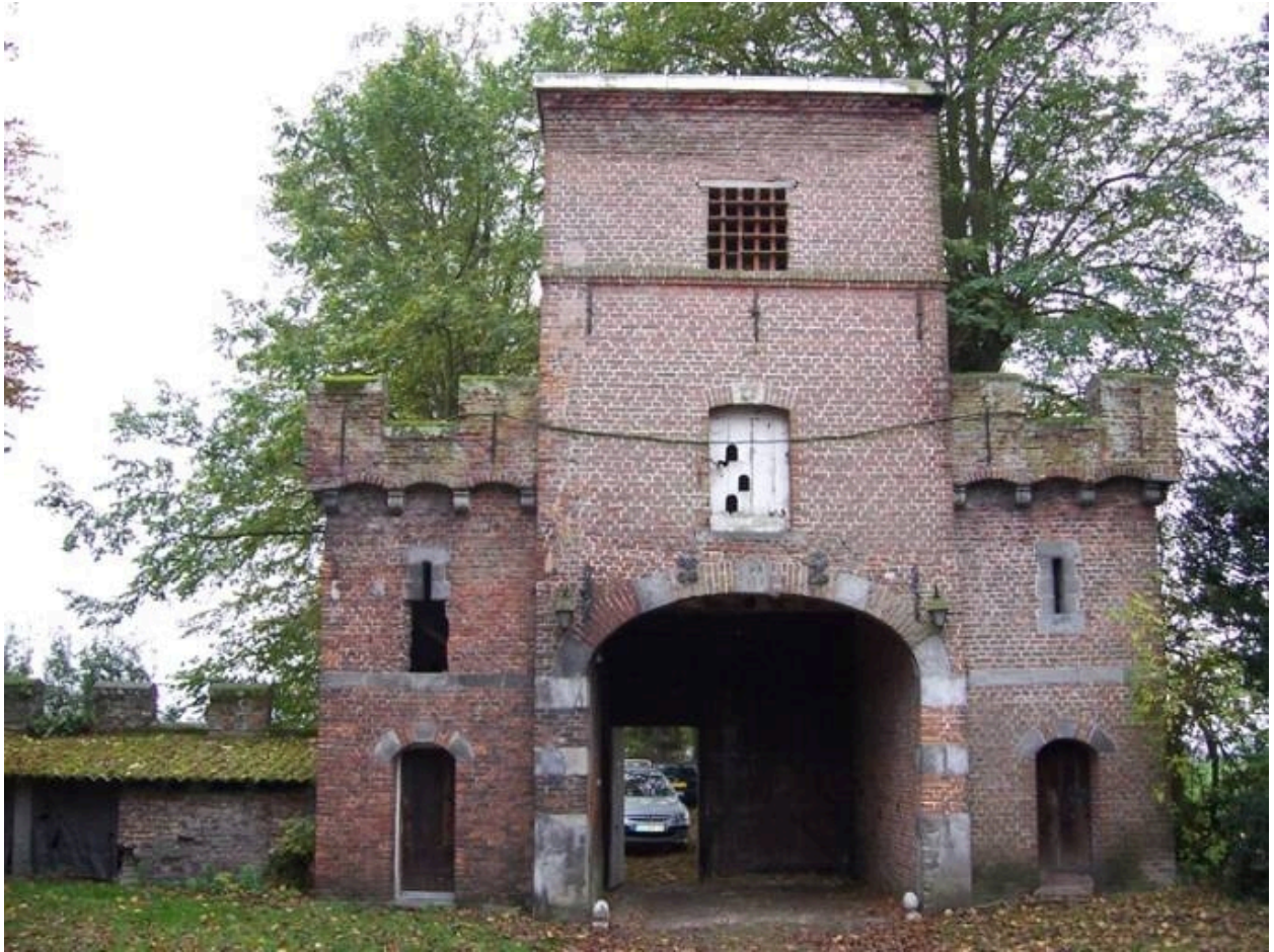
Vue générale du porche-colombier, élévation sur cour.
