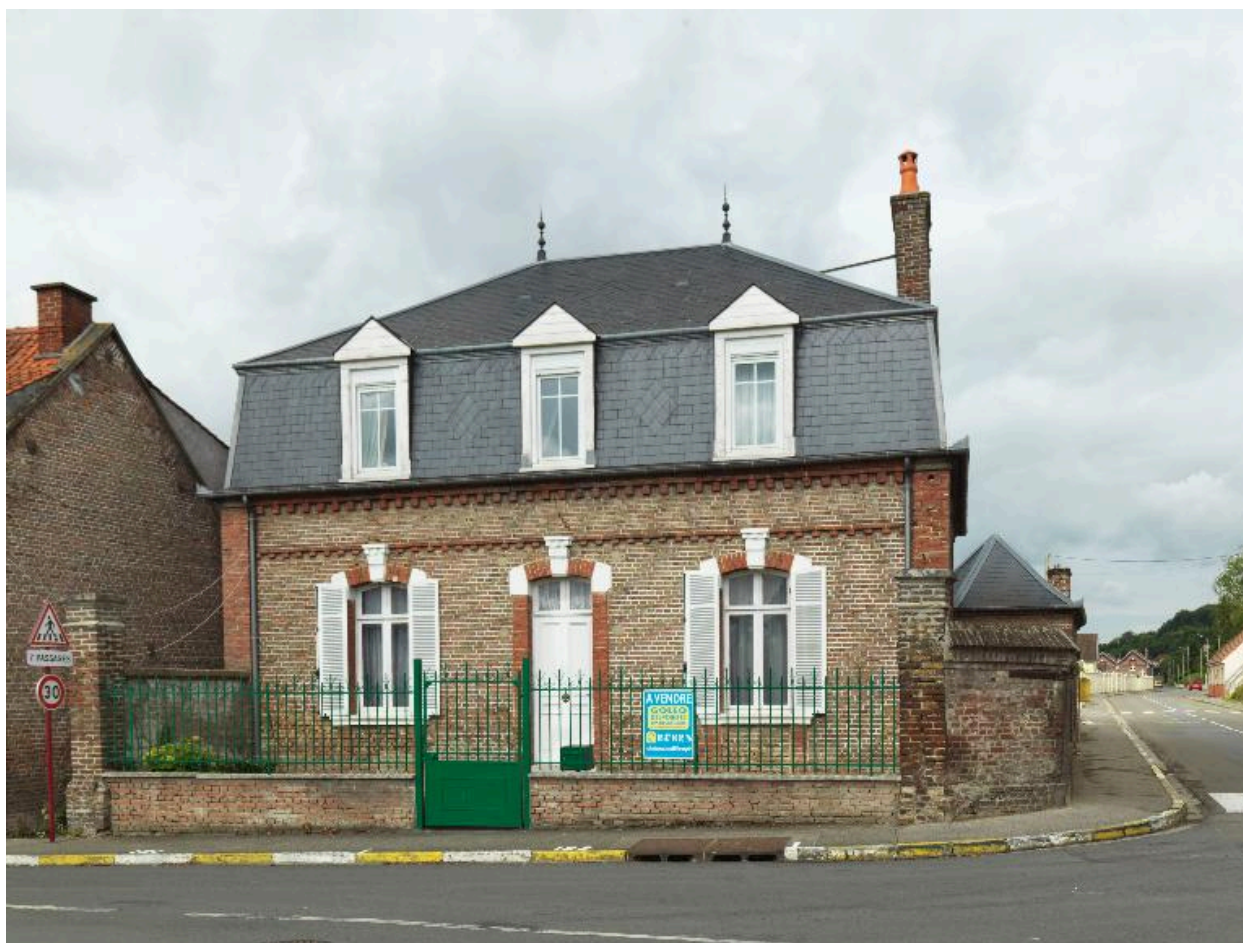
Logement d'encadrement ou de contremaître de la cité des Moulins-Bleus.
