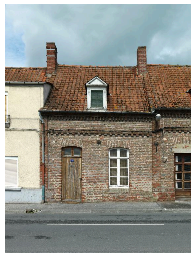
Façade sur rue du logement au 159, rue des Moulins-Bleus. Phot. Thierry Lefébure IVR22_20128000259NUC2A
