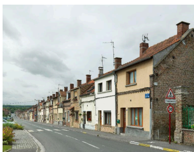
Vue d'ensemble de la cité ouvrière des Moulins-Bleus, vers le sud. Phot. Thierry Lefébure IVR22_20128000256NUC2A
