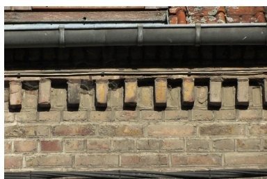
Date de 1887 peinte sur les modillons en brique de corniche d'un logement de la cité ouvrière. Phot. Bertrand Fournier IVR22_20138016179NUC2A
