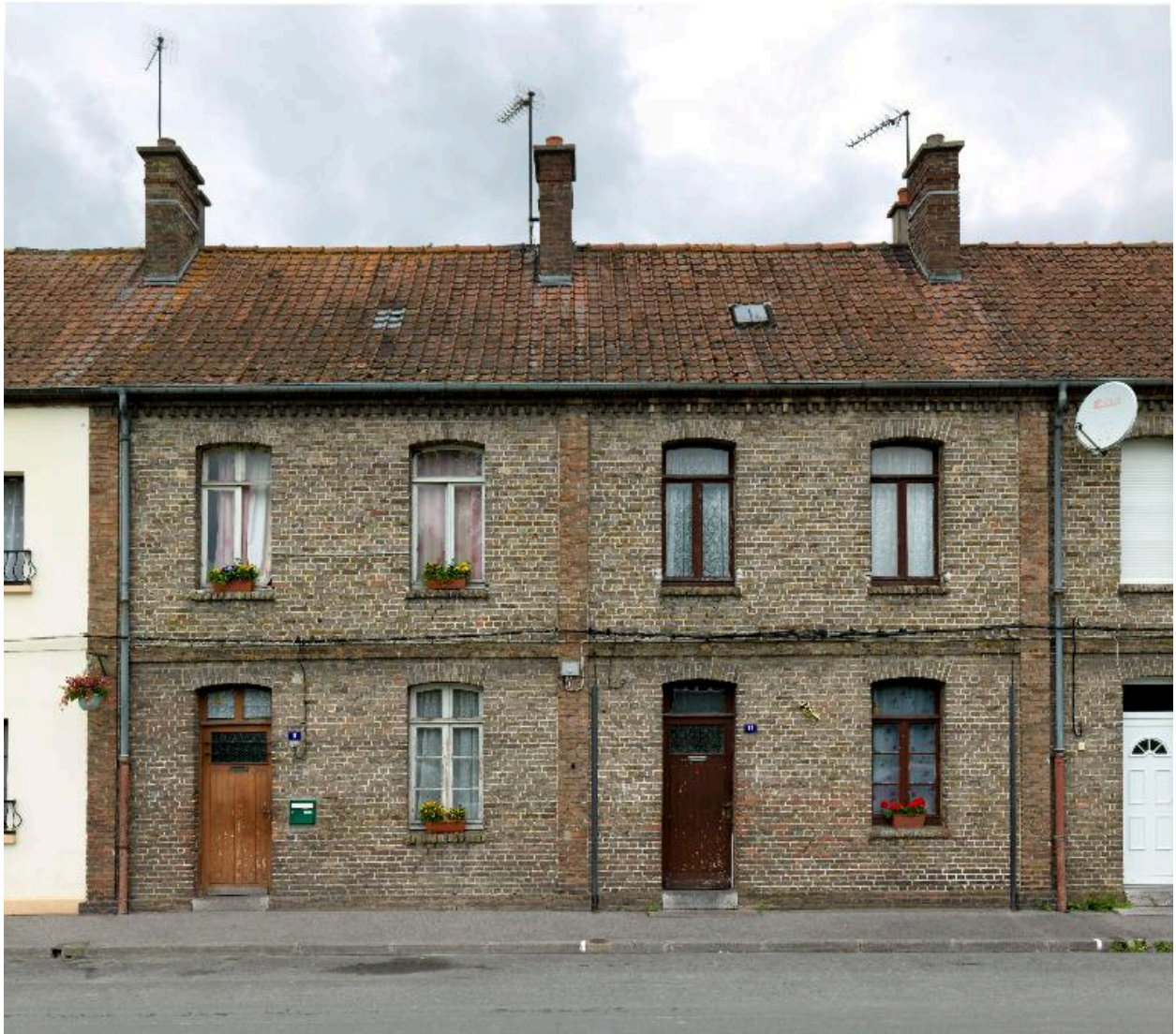
Façade sur rue des logements de cadre.
