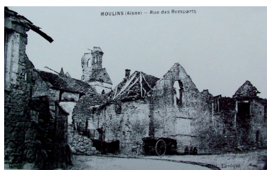
Vue de la rue des Remparts en ruines (coll. part). Phot. Inès Guérin IVR22_20030202510NUCAB
