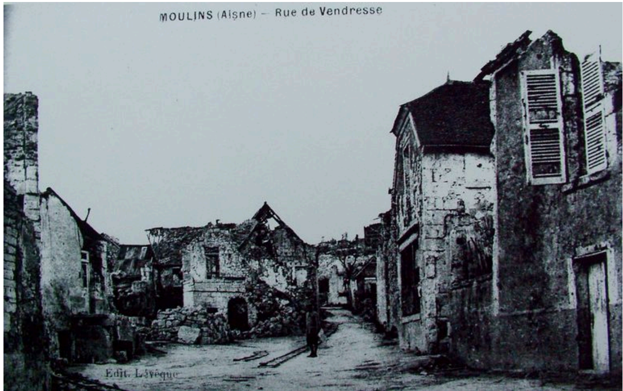
Vue de la rue de Vendresse en ruines (coll. part).
