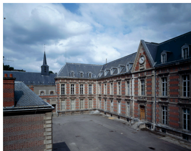
Le bâtiment de 1879, côté cour. Phot. Thierry Lefébure IVR22_19930200949VA
