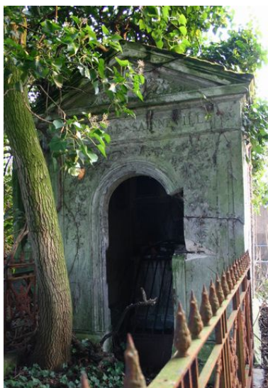
Vue rapprochée de la façade antérieure. Phot. Caroline Vincent IVR22_20078001440NUCA
