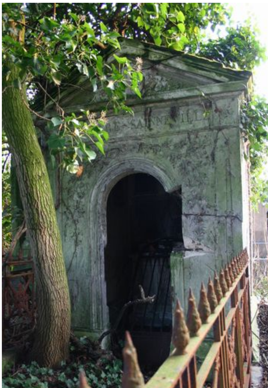
Vue rapprochée de la façade antérieure.
