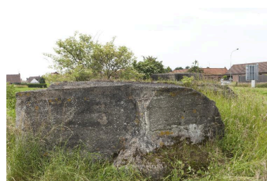
Casemate b, vers le sud Phot. Jean-Marc Ramette IVR31_20145905592NUCA
