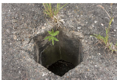
Casemate b. Cheminée du périscopier sur le couvrement Phot. Jean-Marc Ramette IVR31_20145905596NUCA
