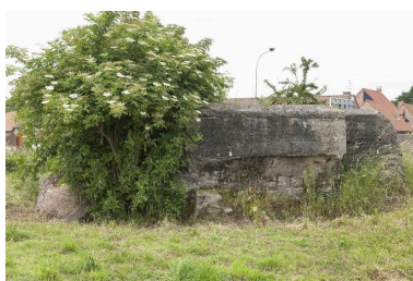
Casemate a, vers le sud-ouest Phot. Jean-Marc Ramette IVR31_20145905599NUCA
