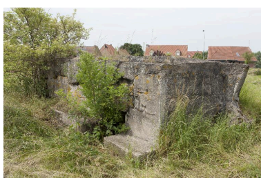
Casemate b. Banquette de tir, vers sud-ouest Phot. Jean-Marc Ramette IVR31_20145905593NUCA
