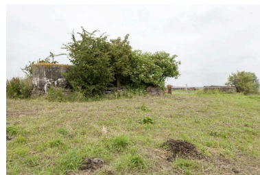
Casemates a, à gauche et b, vers le nord Phot. Jean-Marc Ramette IVR31_20145905591NUCA
