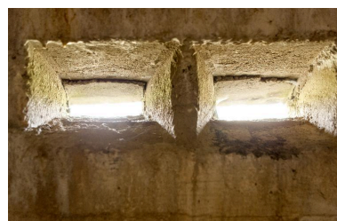
Casemate b. Vue intérieure de l'observatoire bétonné. Embrasures de surveillance Phot. Jean-Marc Ramette IVR31_20145905603NUCA
