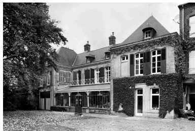
Vue de l'élévation postérieure de l'hôtel, depuis le jardin. Phot. Pierre-Yves Brest IVR22_19990207135Z
