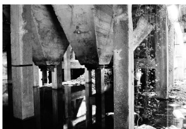
Atelier, salle des goulottes, détail. Phot. Benoît Dufournier IVR22_19908001531Z
