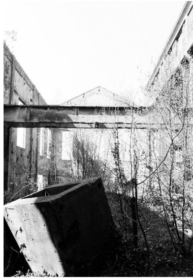
Atelier, vue partielle. Phot. Benoît Dufournier IVR22_19908001540Z
