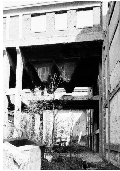
Atelier de fabrication, premier étage, goulottes. Phot. Benoît Dufournier IVR22_19908001541Z
