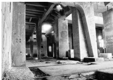
Atelier de fabrication, intérieur, vue partielle. Phot. Benoît Dufournier IVR22_19908001555Z
