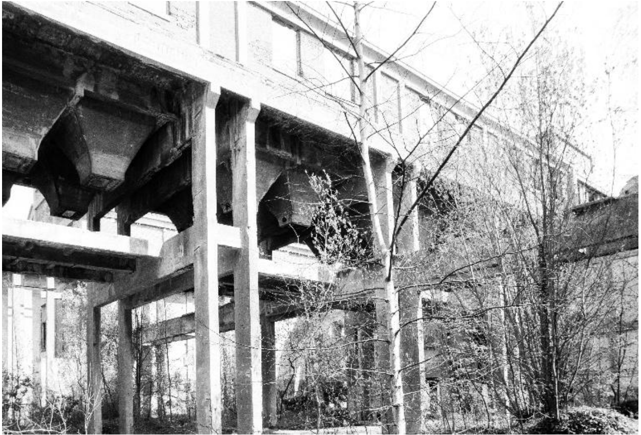
Vue intérieure, premier étage.
