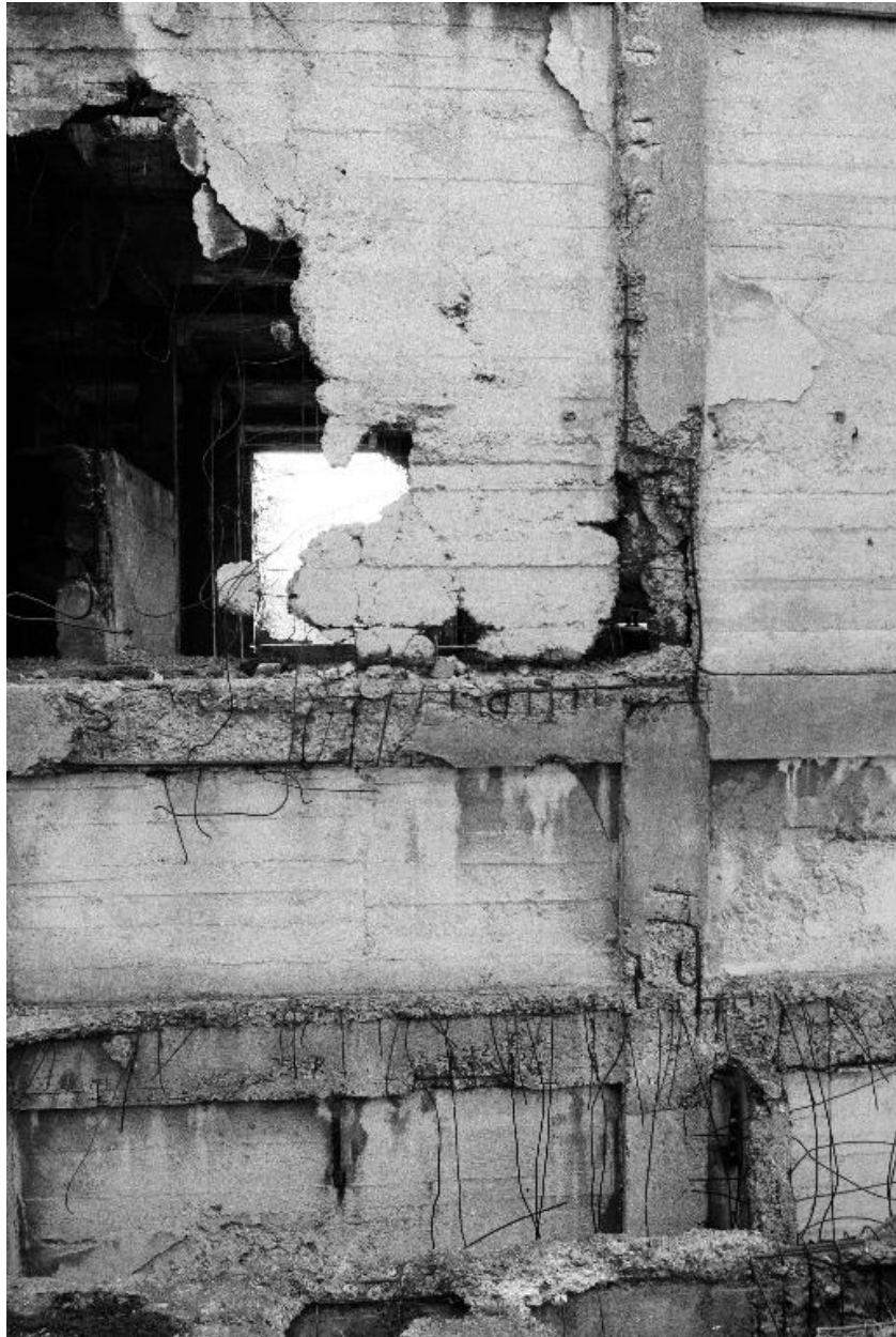
Atelier de fabrication, détail du mur.
