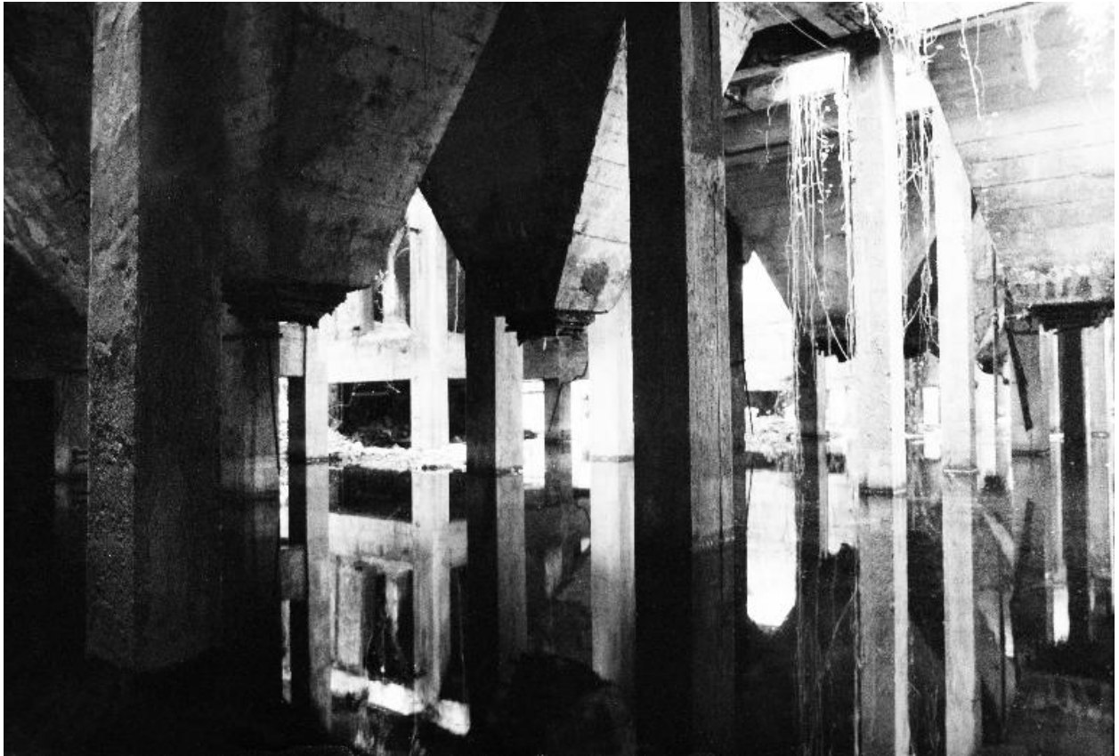
Atelier, salle des goulottes, détail.
