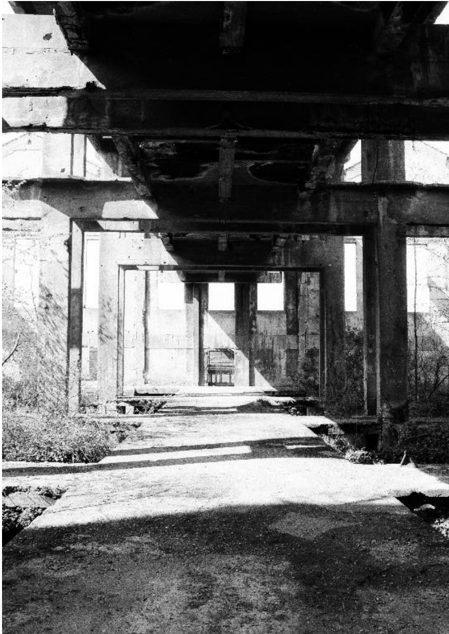
Atelier de fabrication, premier étage, vue intérieure.
