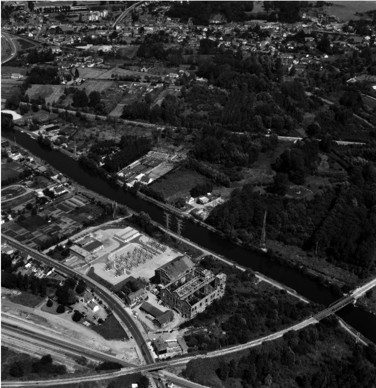
Vue aérienne de 1990, flanc sud-est.
