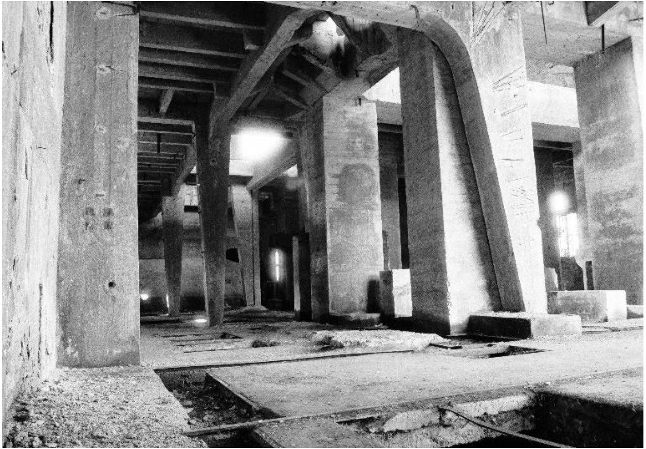
Atelier de fabrication, intérieur, vue partielle.
