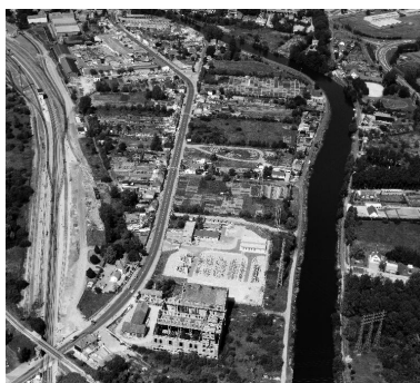
Vue aérienne de 1990, flanc sud. Phot. Phot'R IVR22_19908001655P
