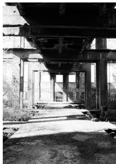
Atelier de fabrication, premier étage, vue intérieure. Phot. Benoît Dufournier IVR22_19908001535Z
