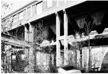
Atelier de fabrication, premier étage, goulottes. Phot. Benoît Dufournier IVR22_19908001542Z
