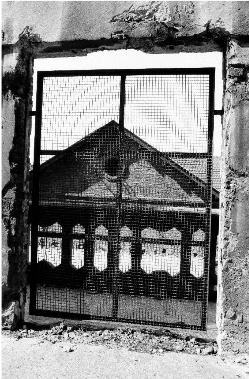
Atelier de fabrication, vue partielle.
