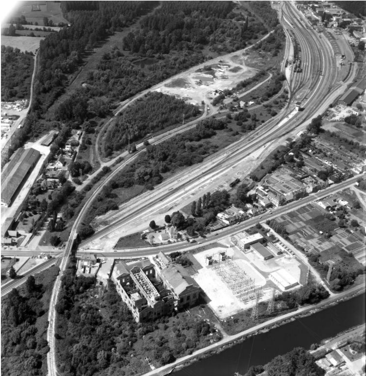
Vue aérienne de 1990, flanc est
