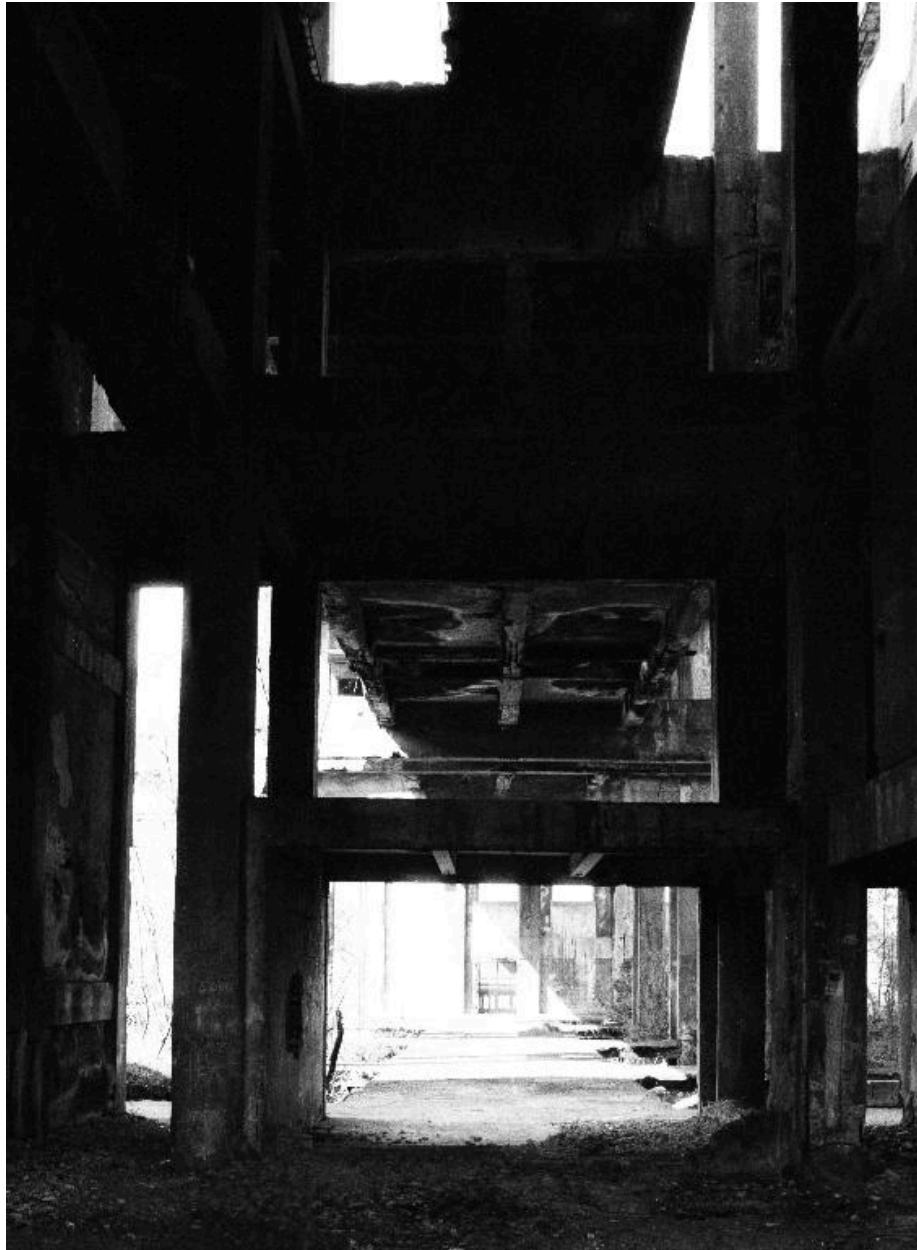
Atelier, premier étage, vue générale.
