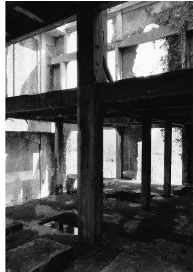
Atelier, salle des machines, premier étage. Phot. Benoît Dufournier IVR22_19908001538Z
