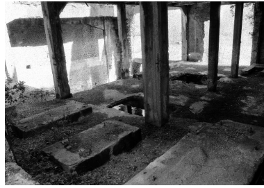
Atelier de fabrication, premier étage, salle des machines. Phot. Benoît Dufournier IVR22_19908001537Z
