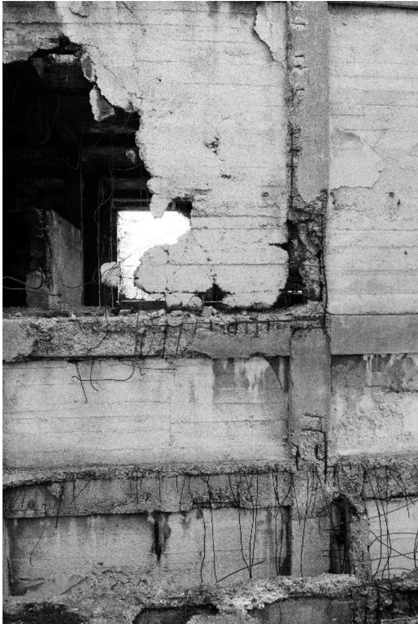
Atelier de fabrication, détail du mur.
