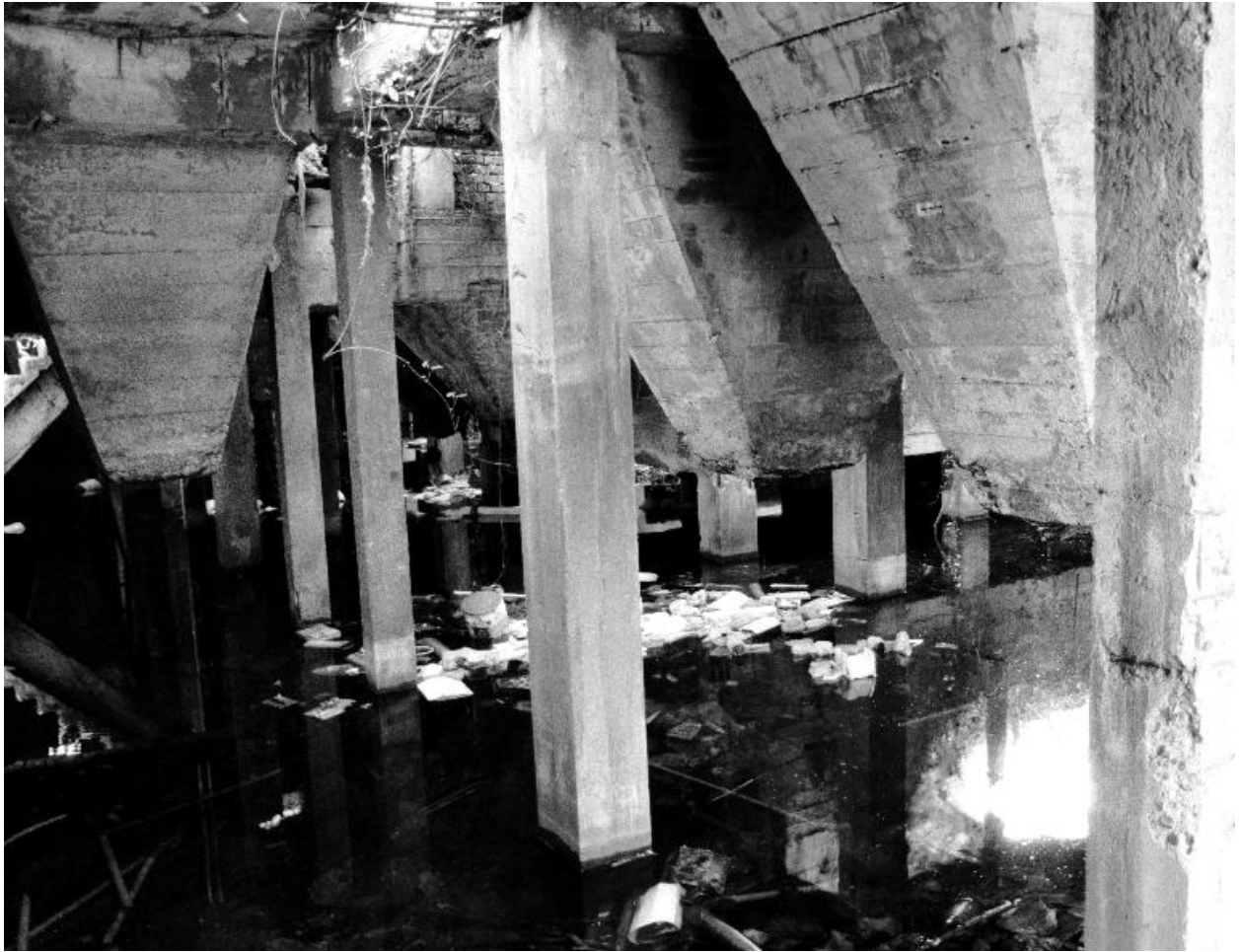
Atelier, salle des goulottes, détail.
