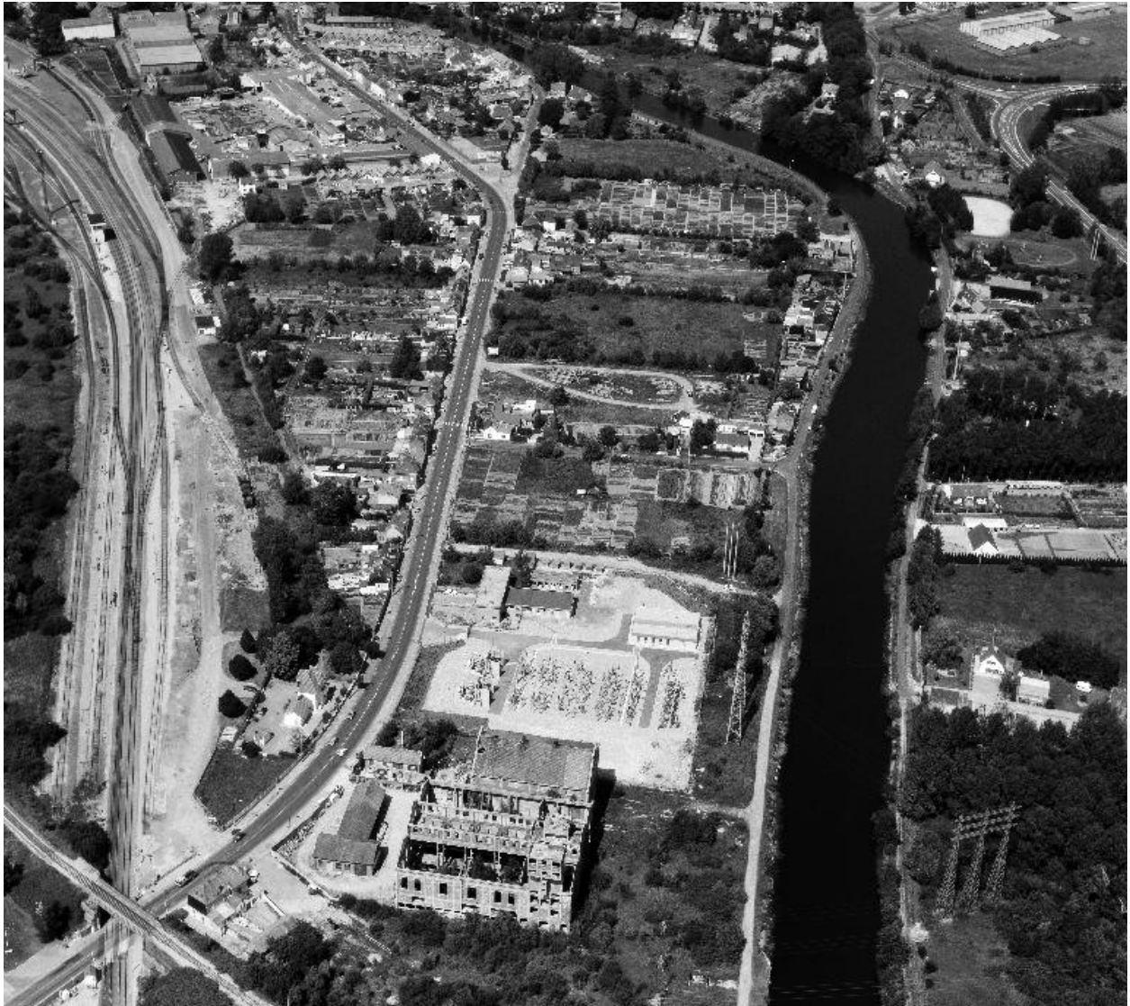
Vue aérienne de 1990, flanc sud.
