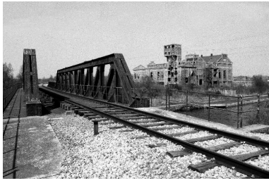
Depuis la rive droite de la Somme, pont-rail de Béthune et atelier de fabrication de la centrale électrique. Phot. Benoît Dufournier IVR22_19908001528Z
