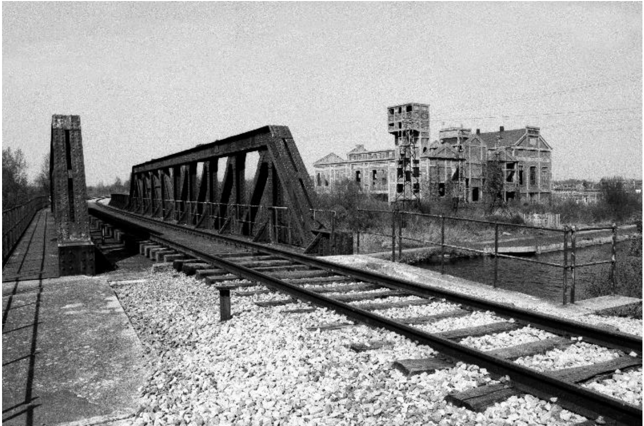
Depuis la rive droite de la Somme, pont-rail de Béthune et atelier de fabrication de la centrale électrique.
