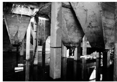
Atelier, rez-de chaussée, salle des goulottes, détail. Phot. Benoît Dufournier IVR22_19908011676Z
