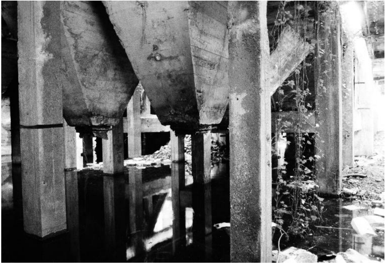
Atelier, salle des goulottes, détail.
