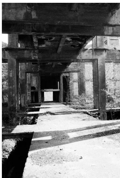
Atelier de fabrication, premier étage.
