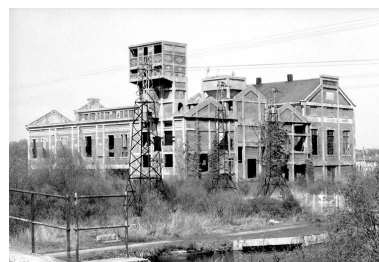
Atelier de fabrication, vue générale Phot. Benoît Dufournier IVR22_19908001524Z
