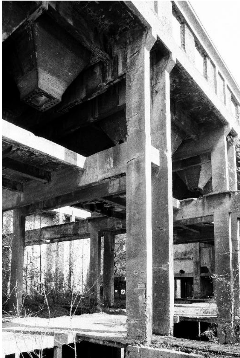
Atelier de fabrication, premier étage.
