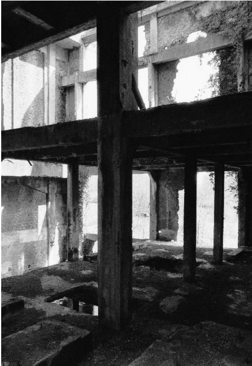
Atelier, salle des machines, premier étage.
