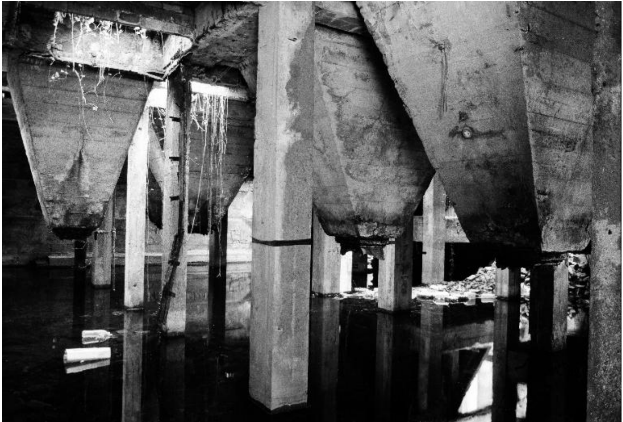
Atelier, rez-de chaussée, salle des goulottes, détail.
