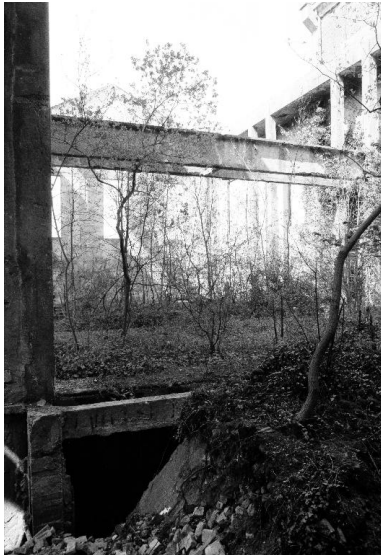
Atelier, vue partielle. Phot. Benoît Dufournier IVR22_19908001539Z
