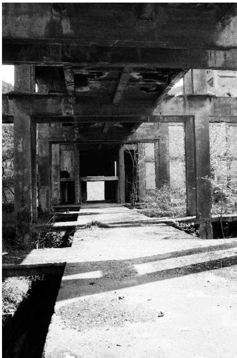
Atelier de fabrication, premier étage.
