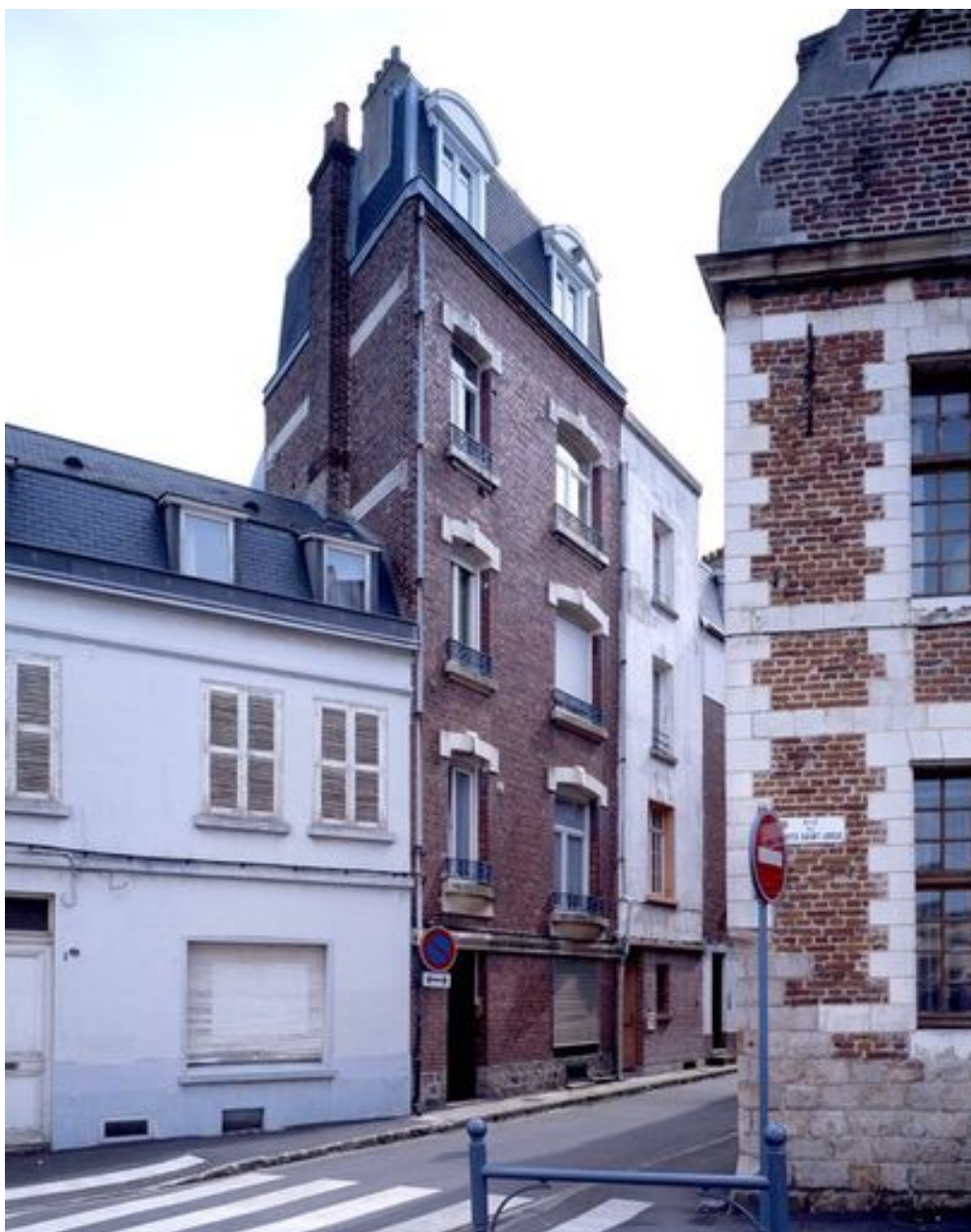
Vue générale, façade rue du Fer-à-Cheval.
