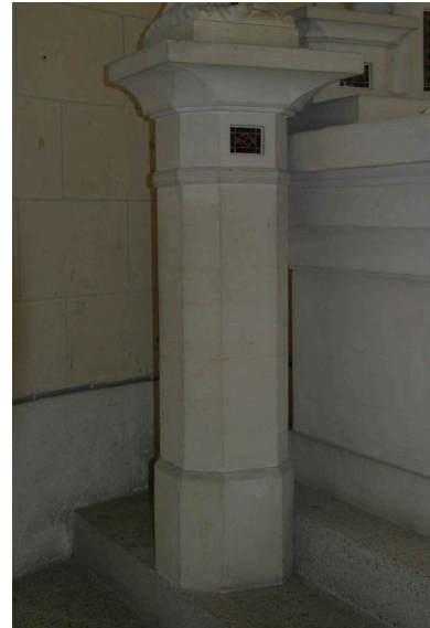
Vue des colonnes flanquant le maître-autel. Phot. Irwin Leullier IVR22_20050201086NUCA
