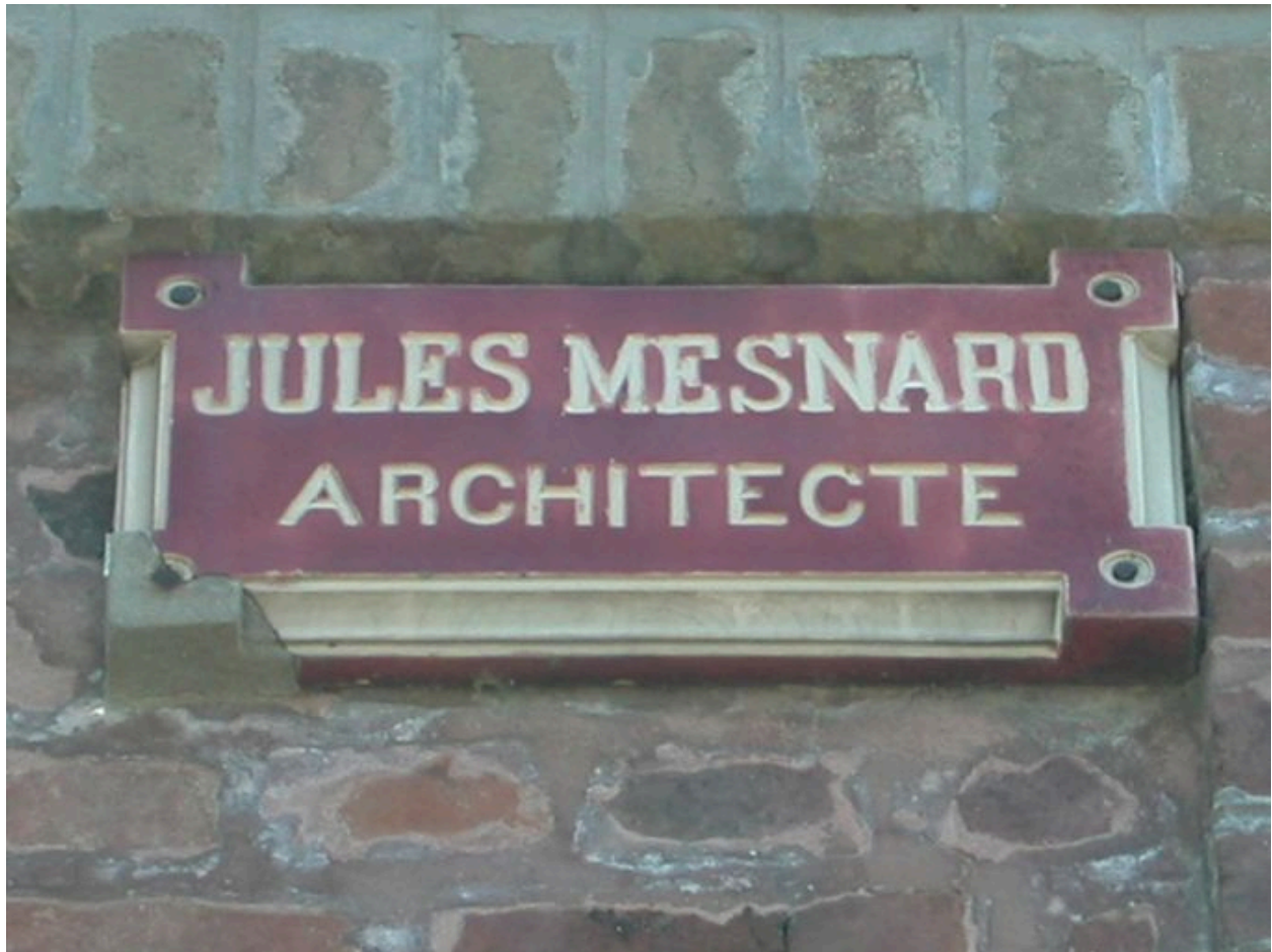
Détail de la signature en façade.
