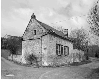
Vue d'ensemble de la maison, depuis l'est.
