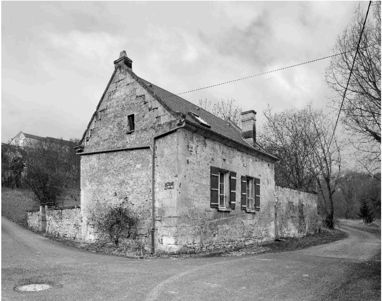
Vue d'ensemble de la maison, depuis l'est.
