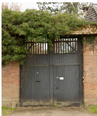
Entrée charretière, n°197 de la rue de Couvremont, vue prise depuis le nord. Phot. Marc Kérignard IVR32_20236000398NUCA
