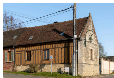
Logis sur rue, n°16 de la rue de Clermont, vue prise depuis l'ouest. Phot. Marc Kérignard IVR32_20236000196NUCA
