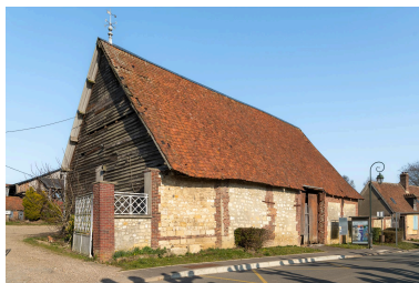
Grange sur rue, n°96 de la rue de Clermont, vue prise depuis le sud-ouest. Phot. Marc Kérignard IVR32_20236000200NUCA
