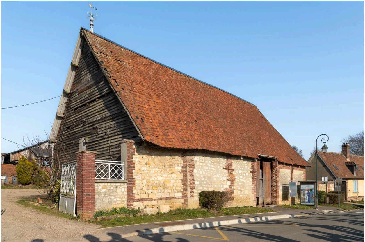
Grange sur rue, n°96 de la rue de Clermont, vue prise depuis le sud-ouest.
