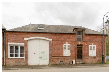
Ancien commerce, 1855, n°189 de la rue de Grandvilliers, vue prise depuis le nord. Phot. Marc Kérignard IVR32_20236000325NUCA
