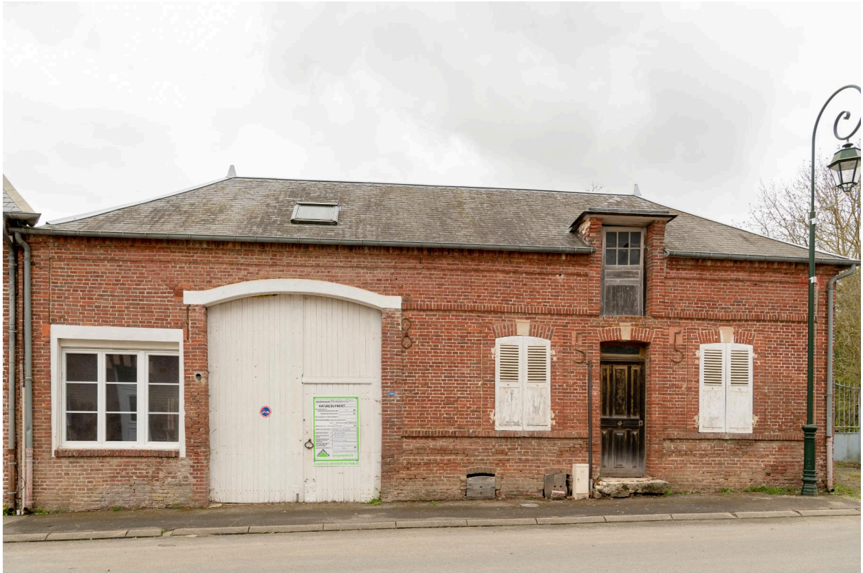
Ancien commerce, 1855, n°189 de la rue de Grandvilliers, vue prise depuis le nord.
