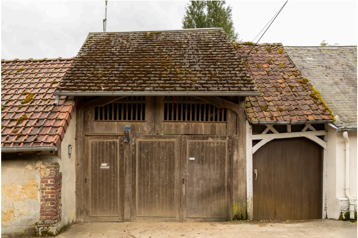
Entrée charretière et porte piétonne, n°57 de la rue de l'Abreuvoir, vue prise depuis le nord.
