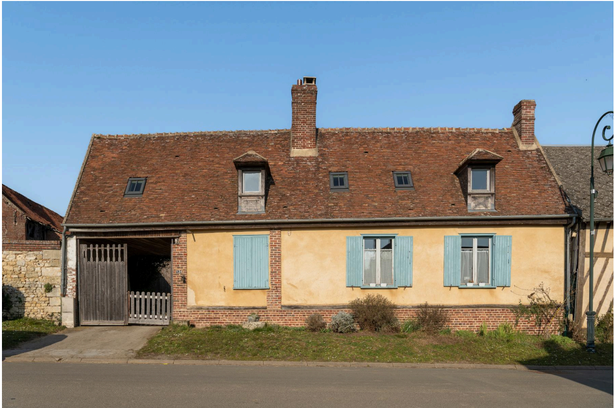
Logis sur rue avec entrée charretière, n° 134 de la rue de Clermont, vue prise depuis le sud.
