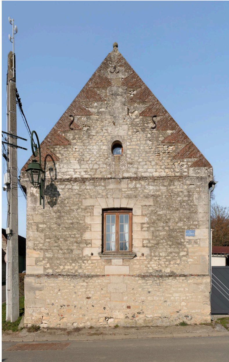
Mur-pignon en pierre, n° 16 de la rue de Clermont, vue prise depuis le sud.
