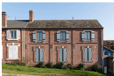
Ancien café, 1871, n°141 de la rue de Clermont, vue prise depuis l'ouest. Phot. Marc Kérignard IVR32_20236000203NUCA
