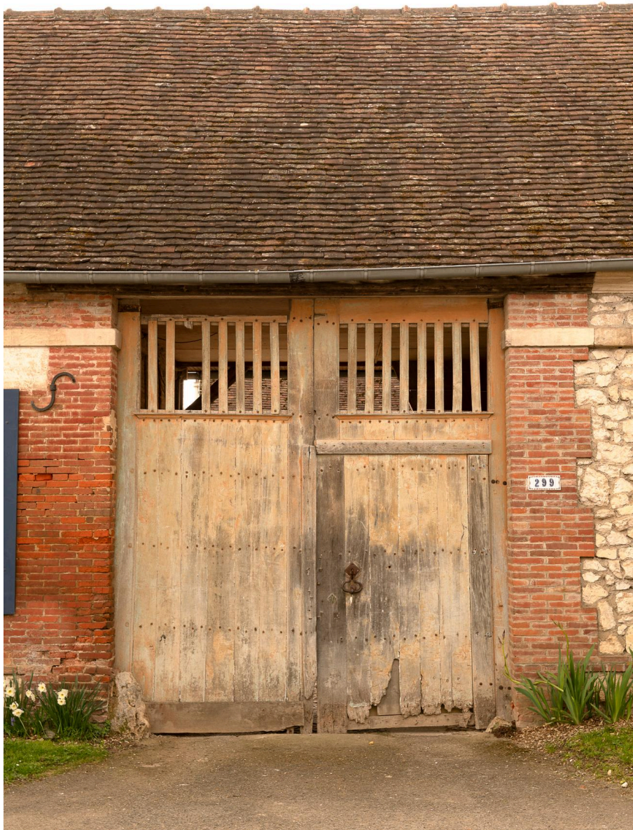
Entrée charretière, n°299 de la rue de Grandvilliers, vue prise depuis le nord.
