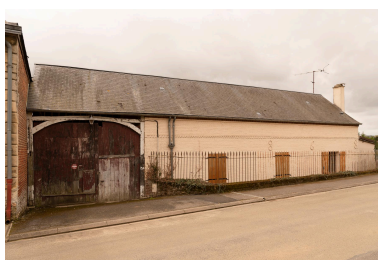
Logis sur rue avec entrée charretière, 1868, n°255 de la rue Bulnoise, vue prise depuis le nord. Phot. Marc Kérignard IVR32_20236000309NUCA
