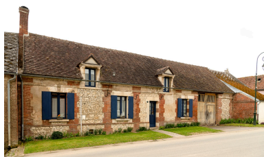
Ancienne poste, n°299 de la rue de Grandvilliers, vue prise depuis le nord. Phot. Marc Kérignard IVR32_20236000324NUCA
