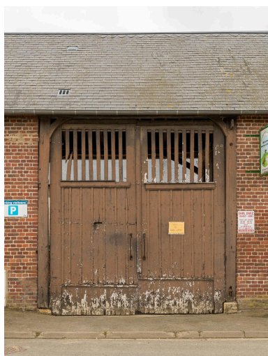
Entrée charretière, n°365 de la rue de Clermont, vue prise depuis le nord. Phot. Marc Kérignard IVR32_20236000389NUCA
