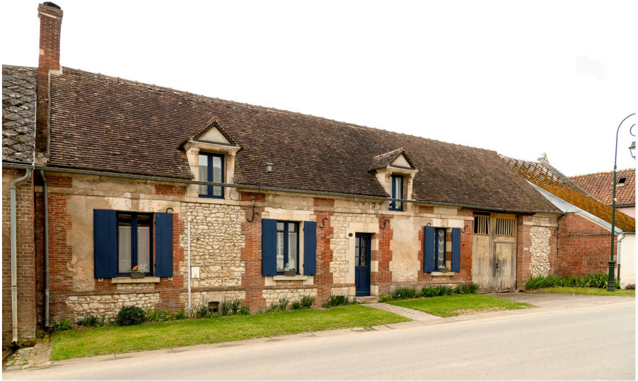
Ancienne poste, n°299 de la rue de Grandvilliers, vue prise depuis le nord.
