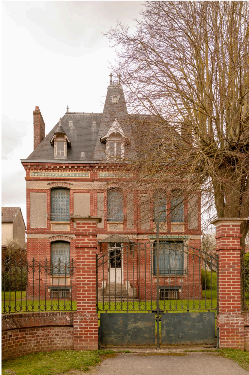
Maison de notable de style anglo-normand, n°460 de la rue du Cayen, vue prise depuis le sud.
