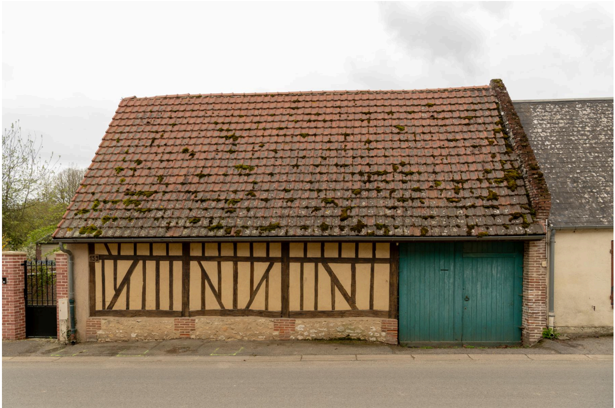
Grange sur rue, n°159 de la rue de Clermont, vue prise depuis le nord.
