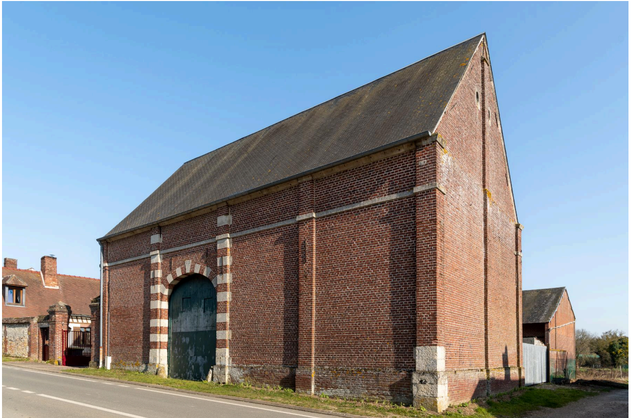
Grange de la ferme à cour au n°544 de la rue de Grandvillers, vue prise depuis l'ouest.
