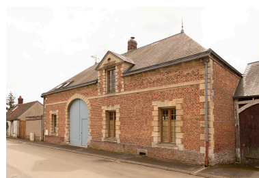
Ancienne boulangerie, n °467 de la rue Bulnoise, vue prise depuis le nord-ouest. Phot. Marc Kérignard IVR32_20236000308NUCA
