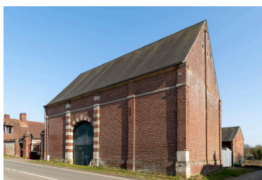
Grange de la ferme à cour au n °544 de la rue de Grandvillers, vue prise depuis l'ouest. Phot. Marc Kérignard IVR32_20236000188NUCA
