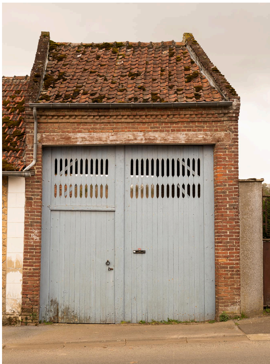
Entrée charretière, n°223 de la rue de Grandvilliers, vue prise depuis le nord.
