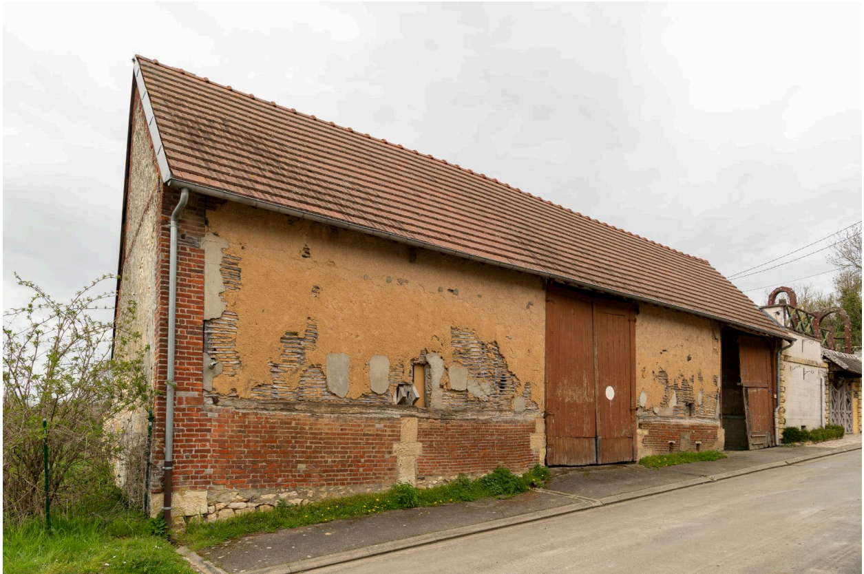
Grange sur rue, n°85 de la rue du Prieuré, vue prise depuis le sud-est.
