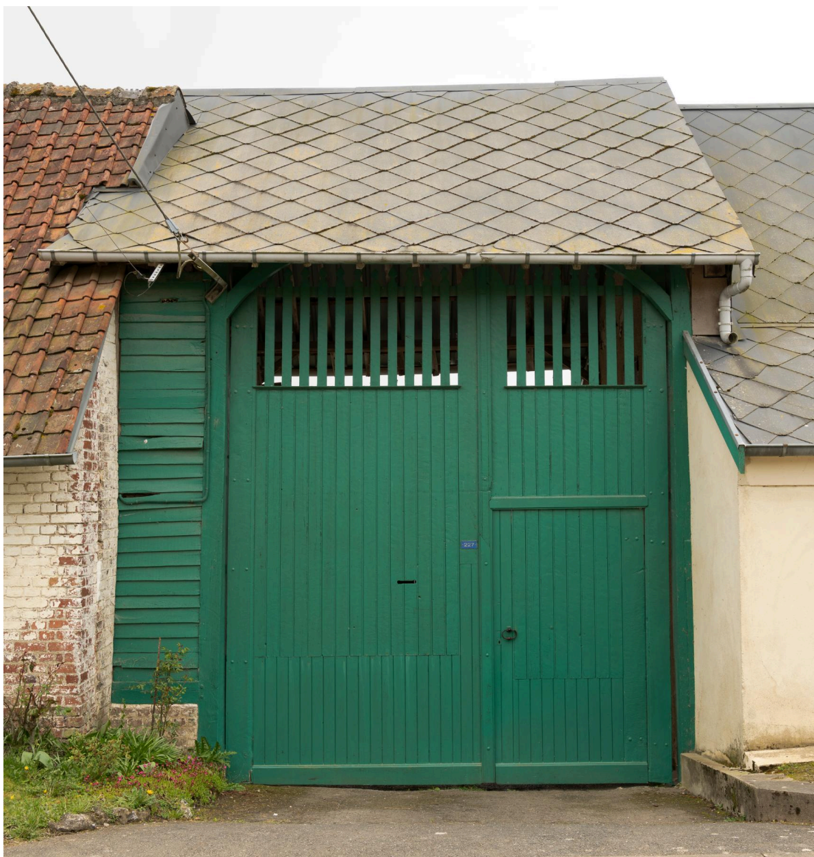
Entrée charretière, n°227 de la rue de Couvremont, vue prise depuis le nord.
