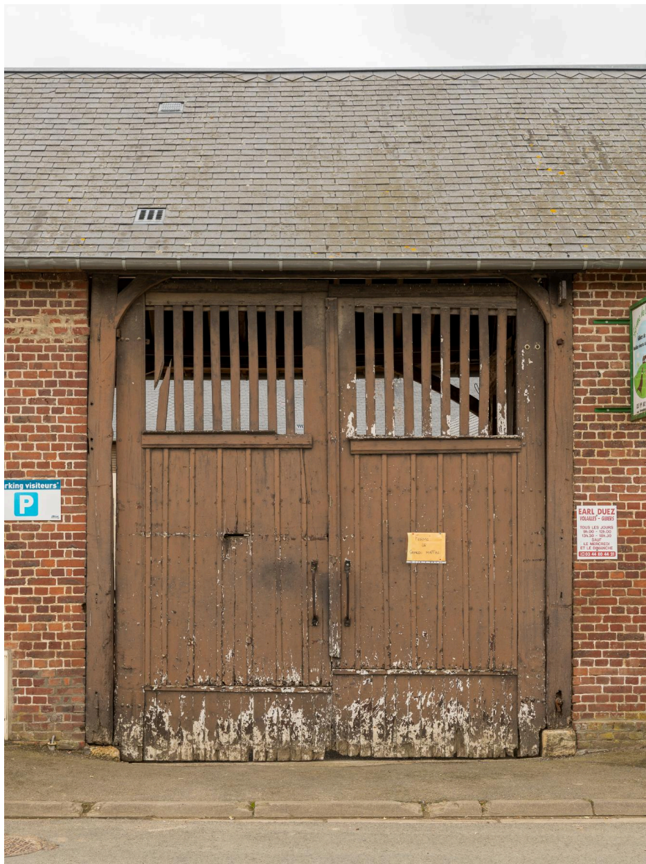
Entrée charretière, n°365 de la rue de Clermont, vue prise depuis le nord.
