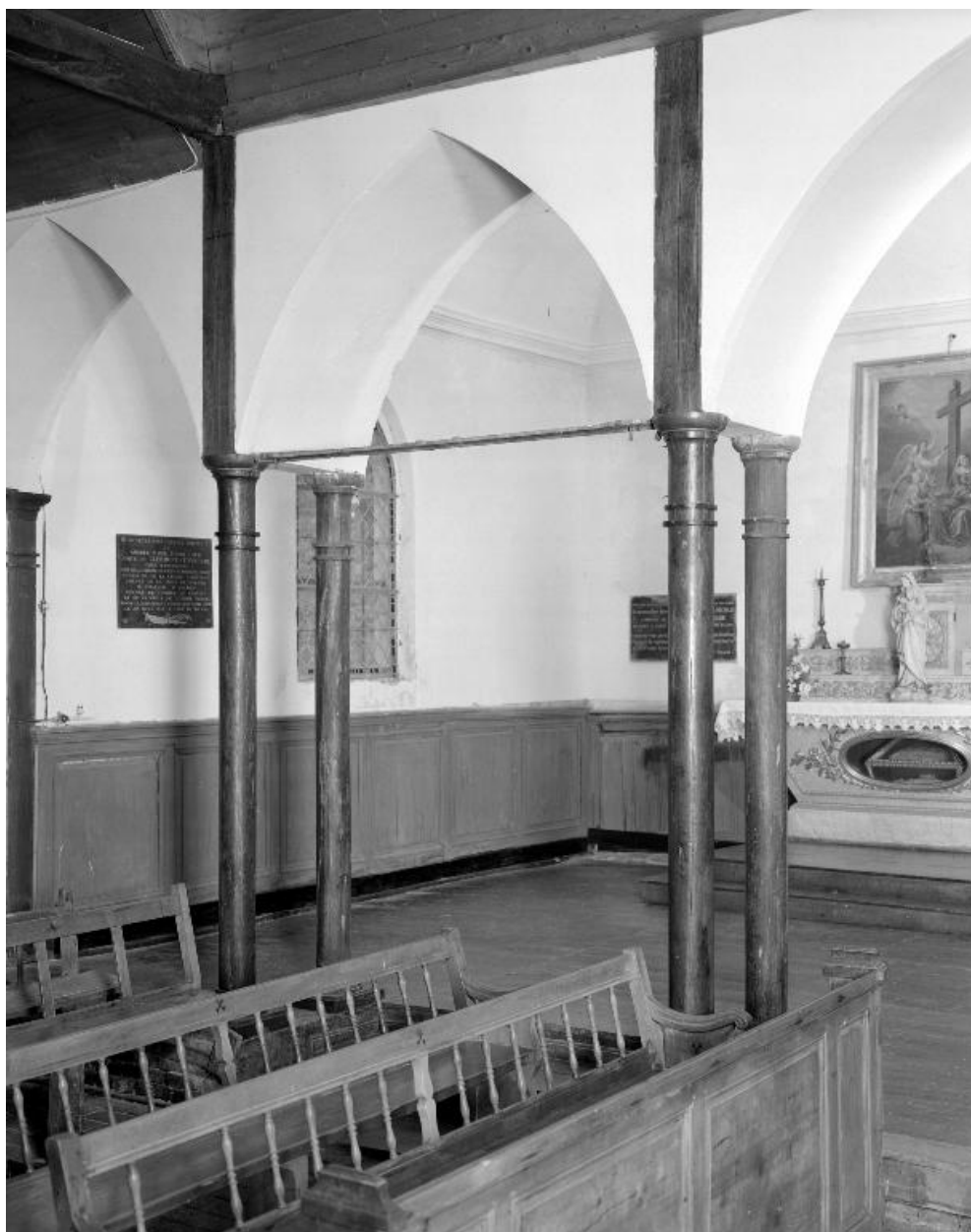
Vue intérieure : colonnes de bois séparant la nef de la chapelle nord.
