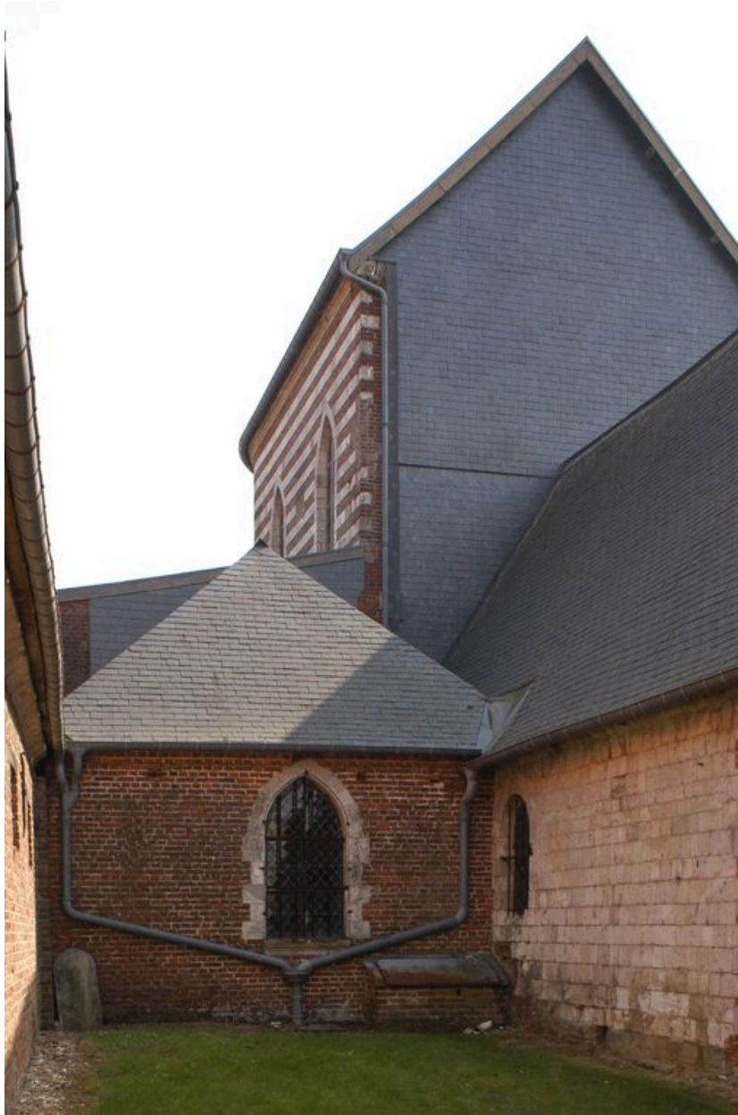
Vue du transept et du mur nord.
