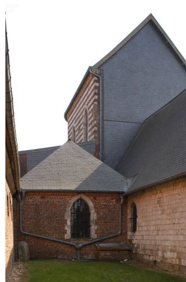
Vue du transept et du mur nord.
