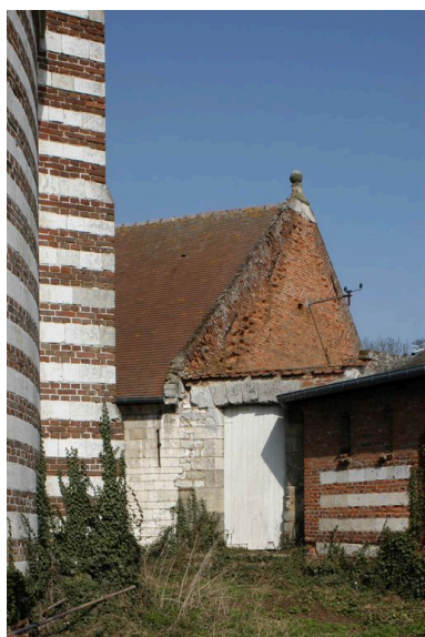
Vue de la porte donnant accès à la cour de la ferme. Phot. Thierry Lefébure IVR22_20038000275NUCA
