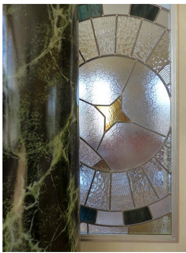
Colonne (peint faux-marbre) et détail de la verrière. Phot. Isabelle Barbedor IVR32_20210205017NUCA
