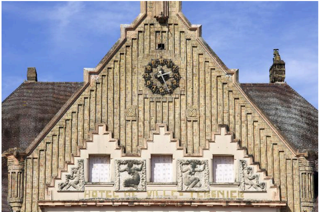
Détail du fronton de la façade principale.
