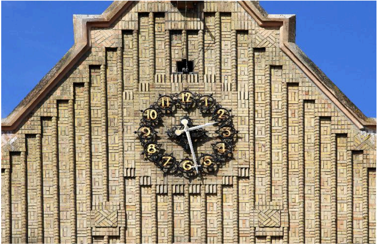
Détail de l'horloge sur le fronton de la façade principale de l'hôtel de ville.
