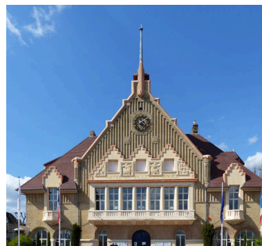
Vue du fronton principal et des baies de l'étage. Phot. Isabelle Barbedor IVR32_20210205011NUCA
