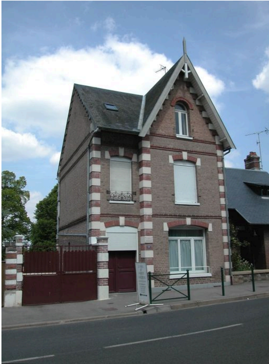
Vue d'ensemble depuis le quai du Romerel.
