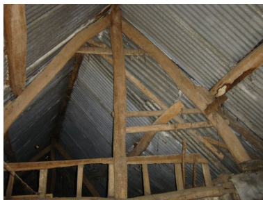
Vue détaillée de la charpente des dépendances. Phot. Inès Guérin IVR22_20068005127NUCA
