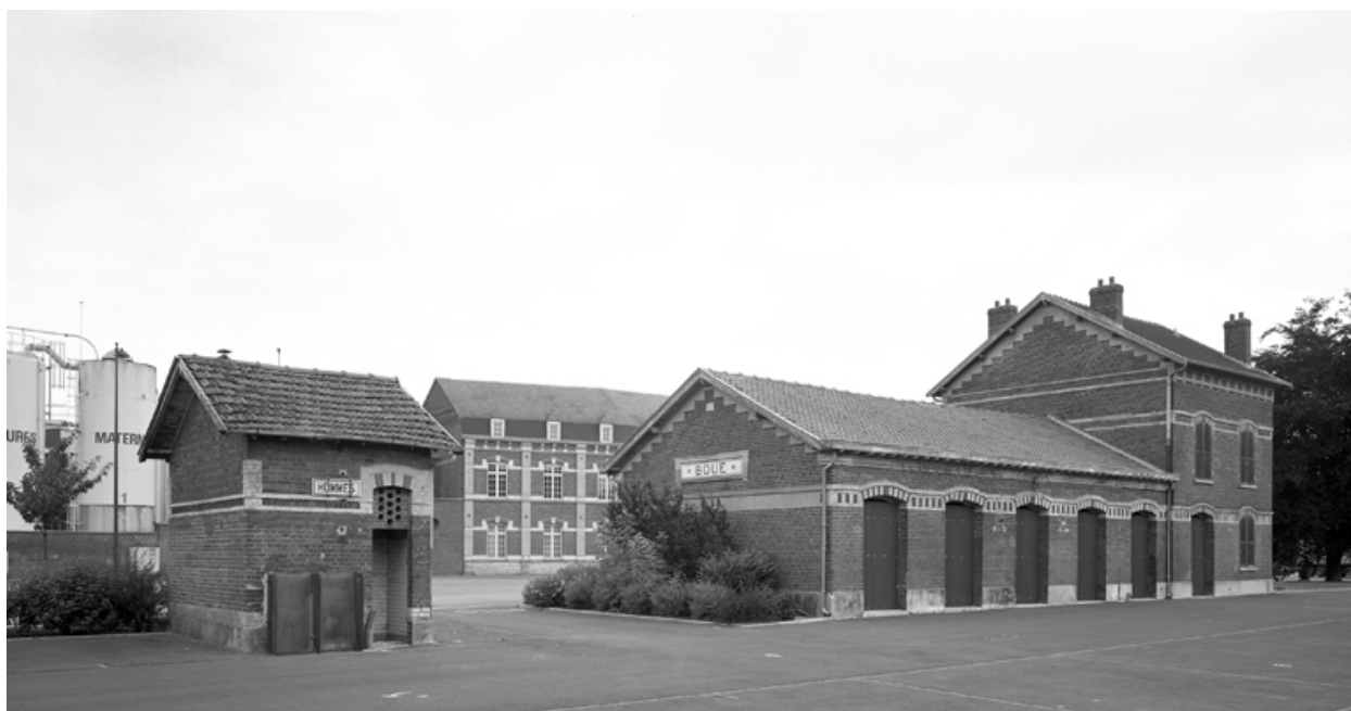
Vue générale, depuis le sud-ouest.
