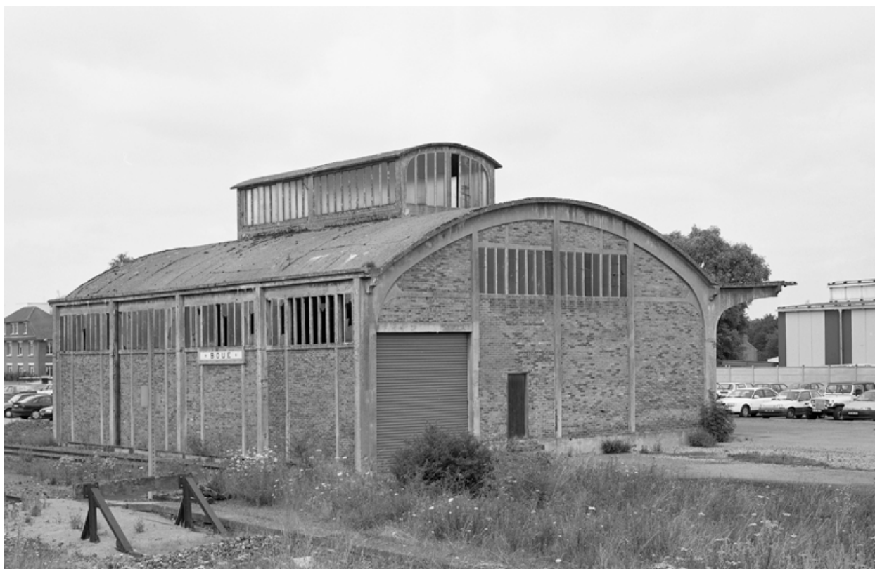
Vue du poste de chargement, depuis l'emplacement des voies.
