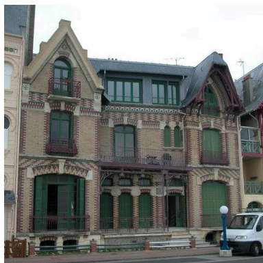
Vue d'ensemble depuis l'esplanade.
