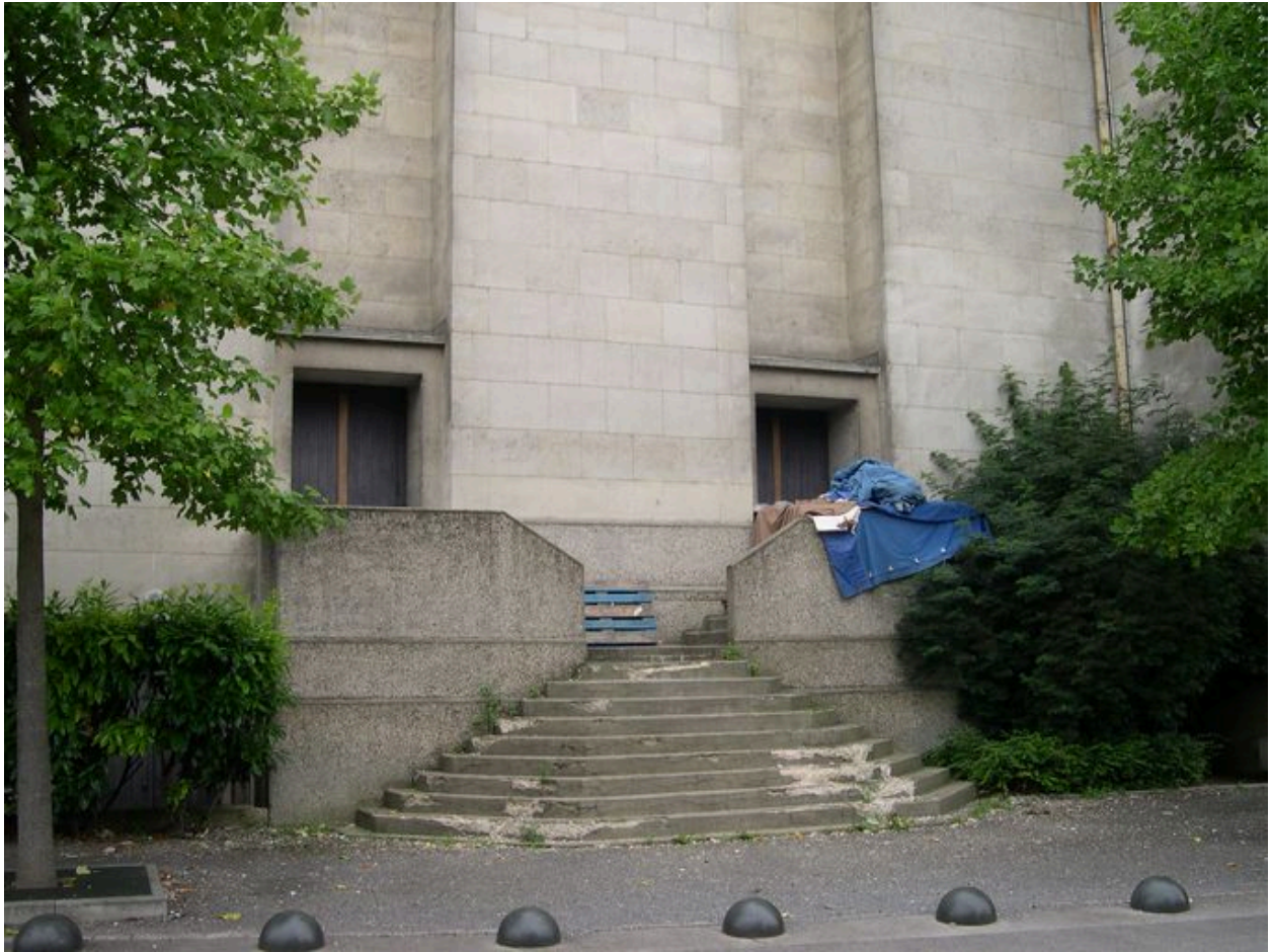
Vue de détail : portails de la façade nord.
