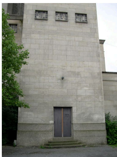
Vue de détail : base de la tour.
