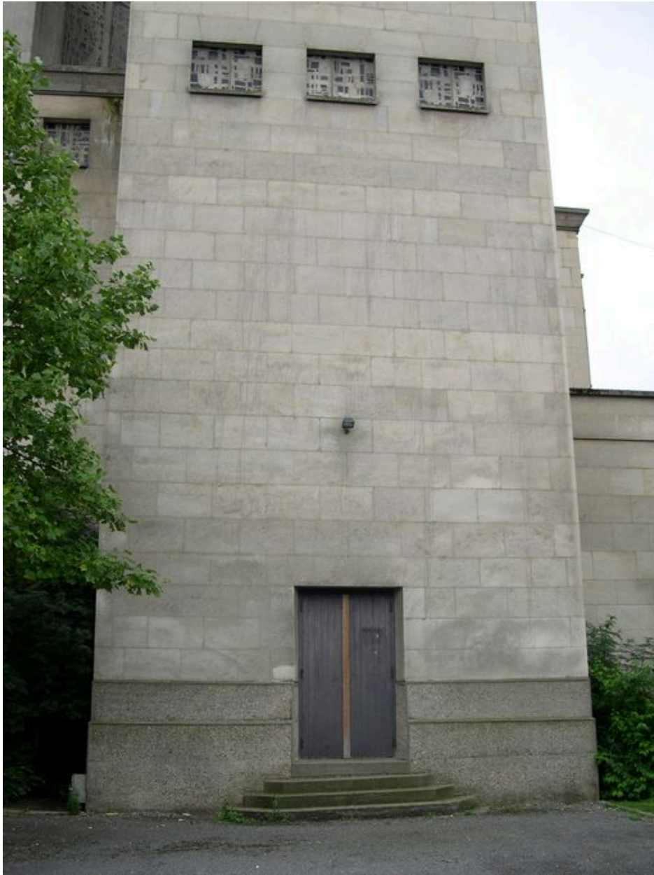
Vue de détail : base de la tour.
