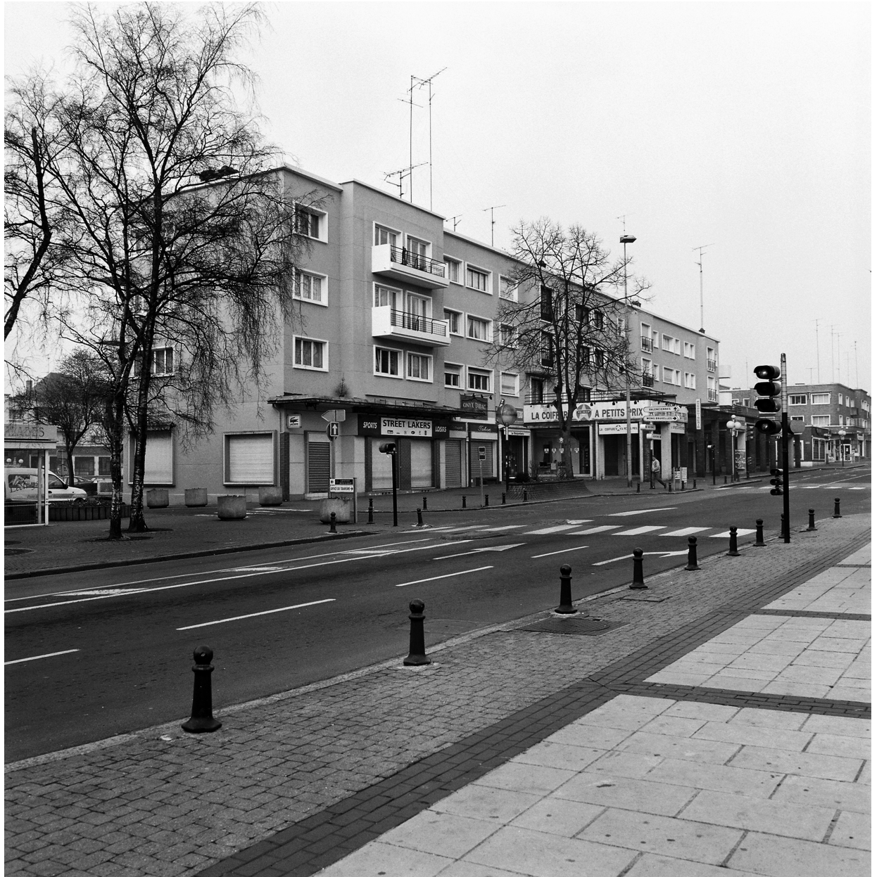
Vue générale de l'élévation sur l'avenue Franklin-Roosevelt.
