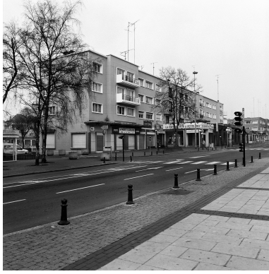
Vue générale de l'élévation sur l'avenue Franklin-Roosevelt. Phot. Thierry Petitberghien IVR31_20035900291X
