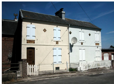
Vue d'ensemble depuis la rue Gros. Phot. Elisabeth Justome IVR22_20048001468NUCA
