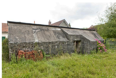
Vue générale, vers le nord-est Phot. Jean-Marc Ramette IVR31_20146203007NUCA
