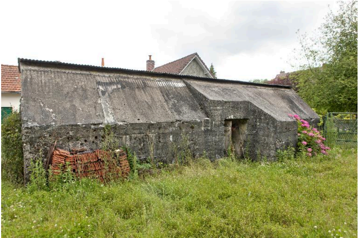
Vue générale, vers le nord-est
