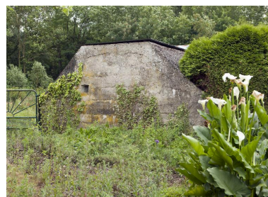
Vue générale vers l'ouest Phot. Jean-Marc Ramette IVR31_20146203010NUCA
