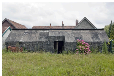
Elévation sud avec la ferme en second plan Phot. Jean-Marc Ramette IVR31_20146203009NUCA
