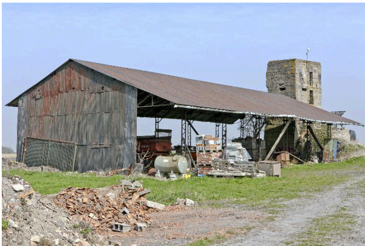
Vue générale vers le nord-est
