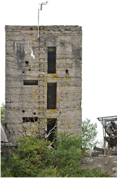
Tour d'observation, élévation sud Phot. Jean-Marc Ramette IVR31_20145904443NUCA
