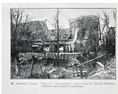
La tour de communication optique intégrée à la casemate de commandement. In :Studies of German defences near Lille Phot. Pierre Thibaut IVR32_20165901711NUCA
