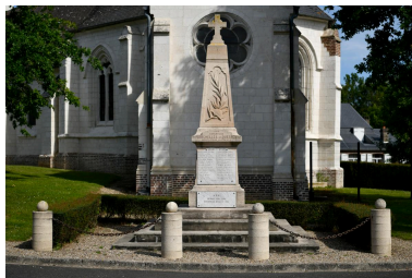
Vue générale depuis le sud Phot. Marc Kérignard IVR22_20228000183NUCA
