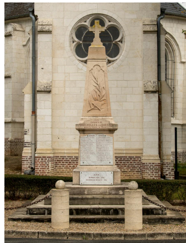
Vue générale depuis le sud Phot. Marc Kérignard IVR22_20228000297NUCA
