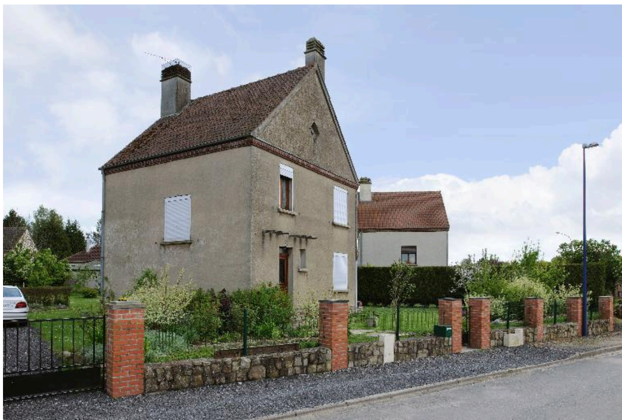
Maison du 2 chemin de Huleux.
