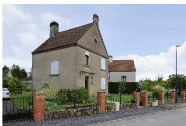
Maison du 2 chemin de Huleux. Phot. Thierry Lefébure IVR22_20138000156NUC2A
