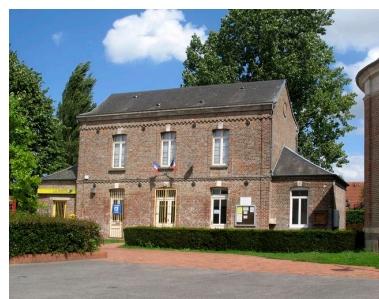
Vue d'ensemble de la façade principale. Phot. Bertrand Fournier IVR22_20088015073NUCA
