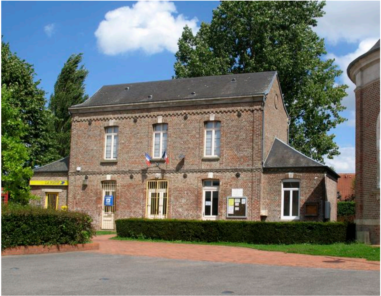
Vue d'ensemble de la façade principale.
