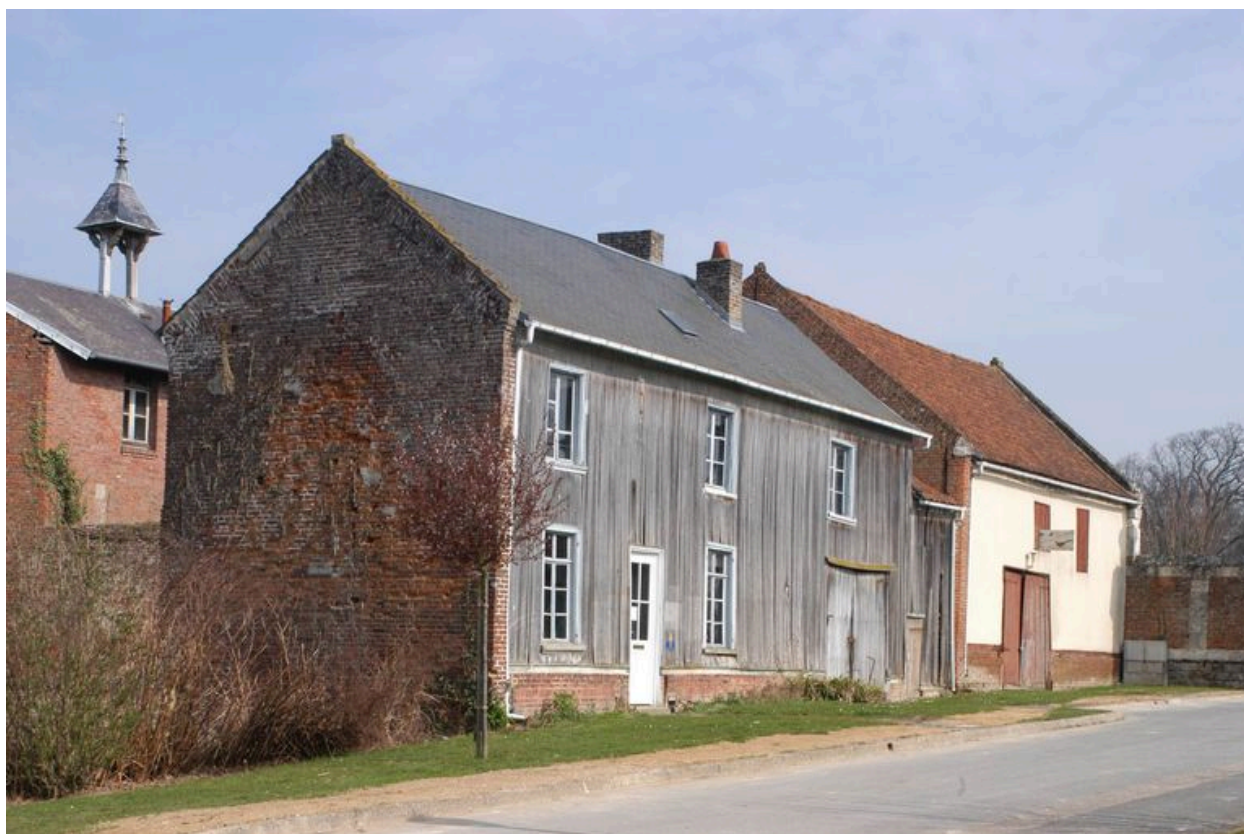
Maison en pan de bois, 11 rue du Château.
