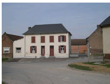
Maison en pan de bois, 7 place de l'Eglise. Phot. Isabelle Barbedor IVR22_20038010148NUCA
