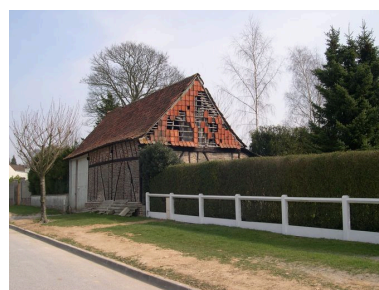
Grange en pan de bois hordé en briques, 17 rue d'Amiens, elle formait initialement un corps de passage. Phot. Isabelle Barbedor IVR22_20038010150NUCA
