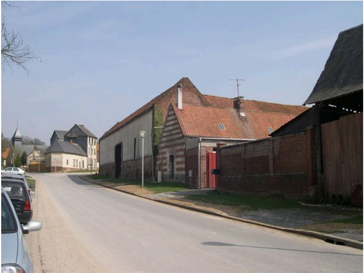
Ferme, 10 rue de l'Eglise. Les bâtiments perpendiculaires à la voie, qui apparaissent sur le cadastre de 1810, appartiennent alors à T. Carette.
