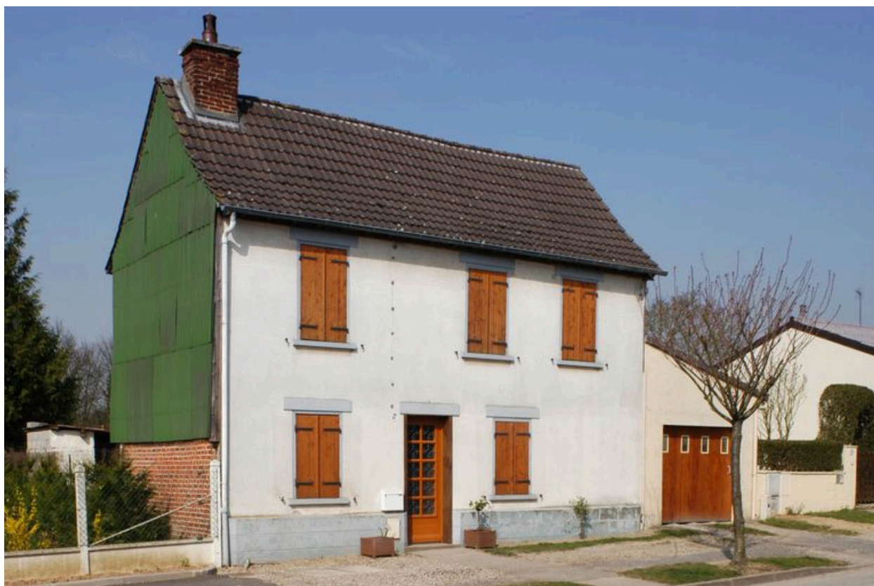
Maison en pan de bois, 14 rue d'Amiens, reconstruite vers 1837 (date d'imposition).
