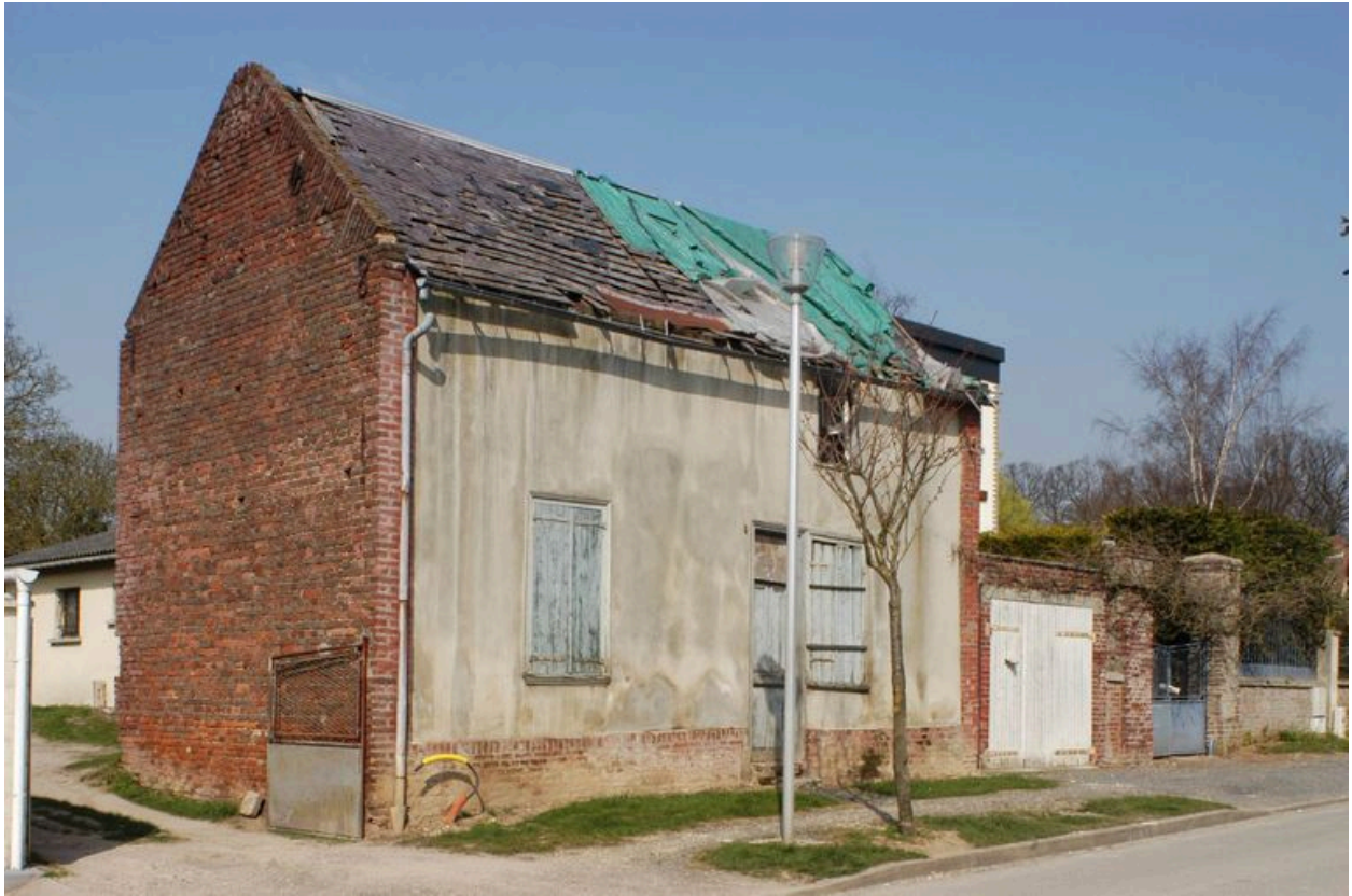
Maison en pan de bois, 20 rue d'Amiens, reconstruite vers 1840 (date d'imposition) et surélevée d'un étage en 1853.
