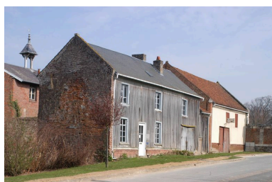
Maison en pan de bois, 11 rue du Château. Phot. Thierry Lefébure IVR22_20038000254NUCA
