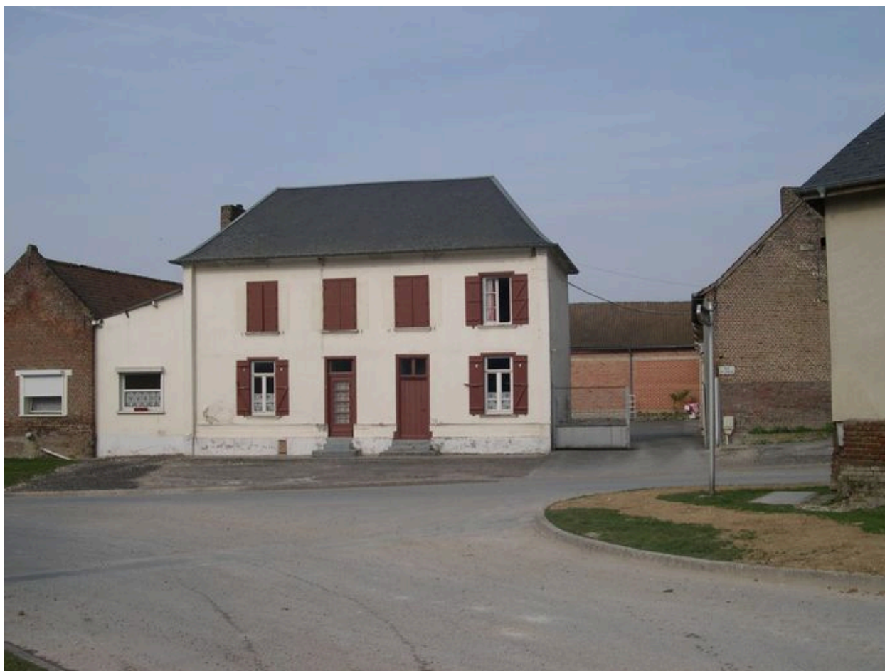
Maison en pan de bois, 7 place de l'Eglise.
