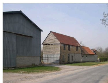
Ferme, 33 rue du Moulin. Le logis en terre, visible sur le cadastre de 1810, a été prolongé vers 1837 (date d'imposition) et surélevé en 1851. Phot. Isabelle Barbedor IVR22_20038010335NUCA
