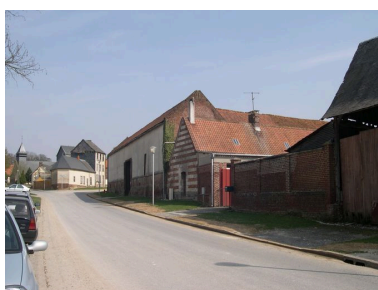
Ferme, 10 rue de l'Eglise. Les bâtiments perpendiculaires à la voie, qui apparaissent sur le cadastre de 1810, appartiennent alors à T. Carette. Phot. Isabelle Barbedor IVR22_20038011207NUCA
