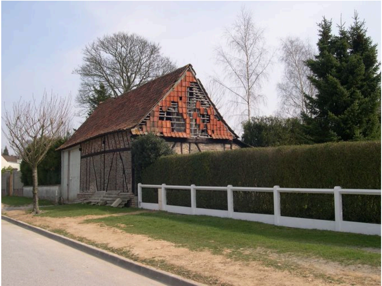
Grange en pan de bois hourdé en briques, 17 rue d'Amiens, elle formait initialement un corps de passage.
