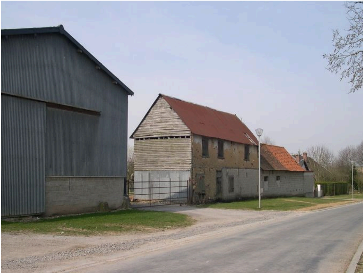
Ferme, 33 rue du Moulin. Le logis en terre, visible sur le cadastre de 1810, a été prolongé vers 1837 (date d'imposition) et surélevé en 1851.
