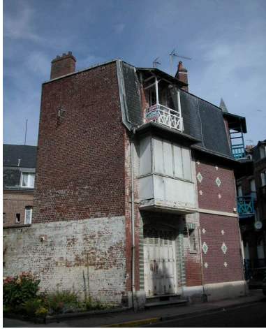
Vue de l'élévation sur la rue Jules Barni. Phot. Elisabeth Justome IVR22_20038005304NUCA
