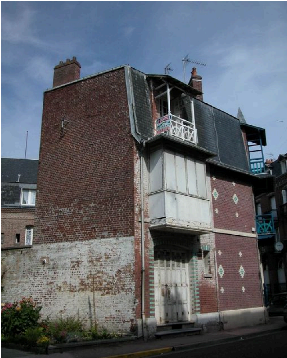
Vue de l'élévation sur la rue Jules Barni.
