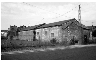
Flanc sud-ouest. Phot. Benoît Dufournier IVR22_19876000315Z
