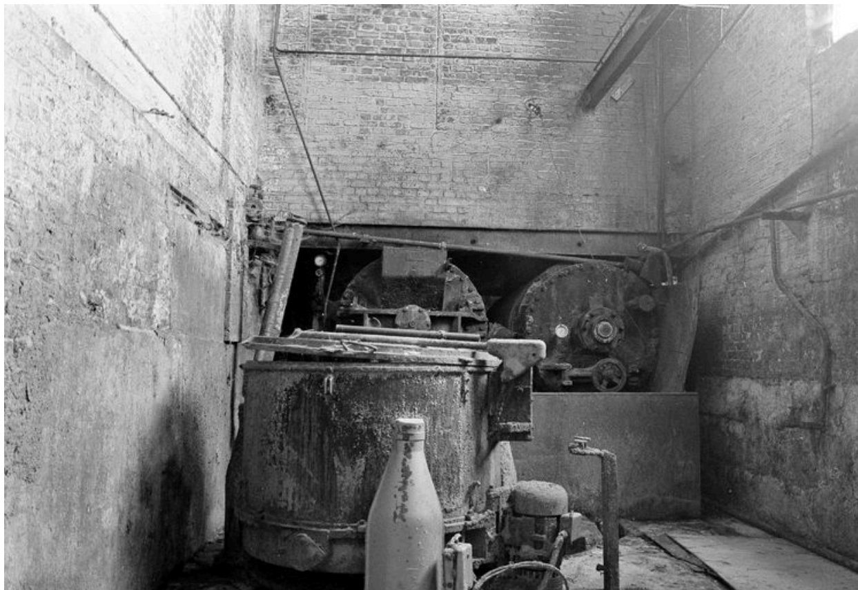
Atelier de fabrication : vue intérieure.
