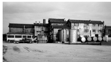
Vue générale : flanc ouest. Phot. Benoît Dufournier IVR22_19876000313Z
