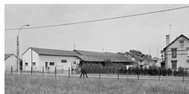
Ateliers de fabrication et magasins en fond de parcelle. Phot. Benoît Dufournier IVR22_19936001639Z
