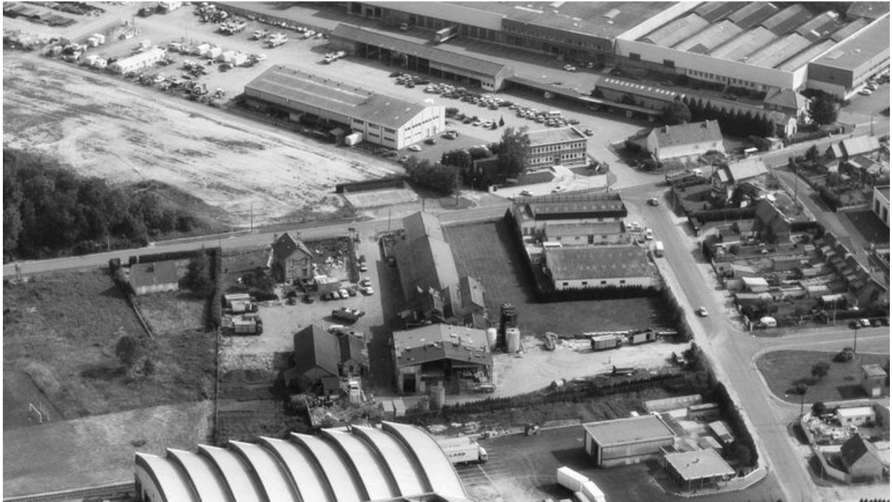
Vue aérienne de l'usine, en 1991.
