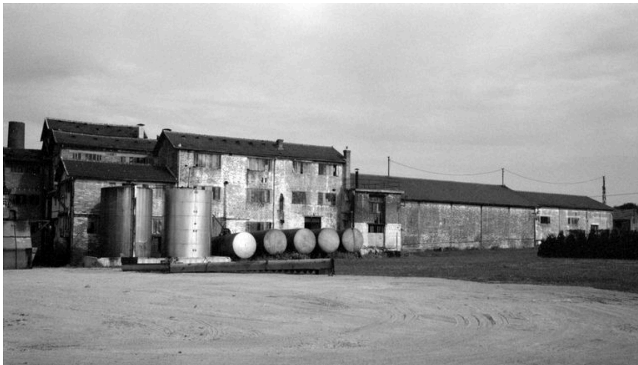
Vue générale : flanc ouest.
