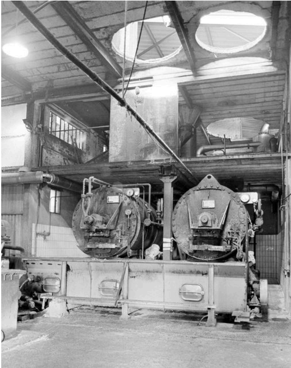
Atelier de fabrication : vue intérieure.
