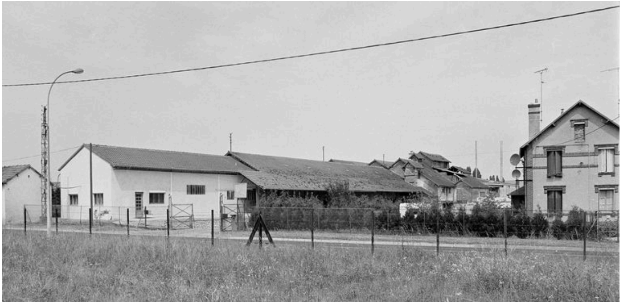
Ateliers de fabrication et magasins en fond de parcelle.
