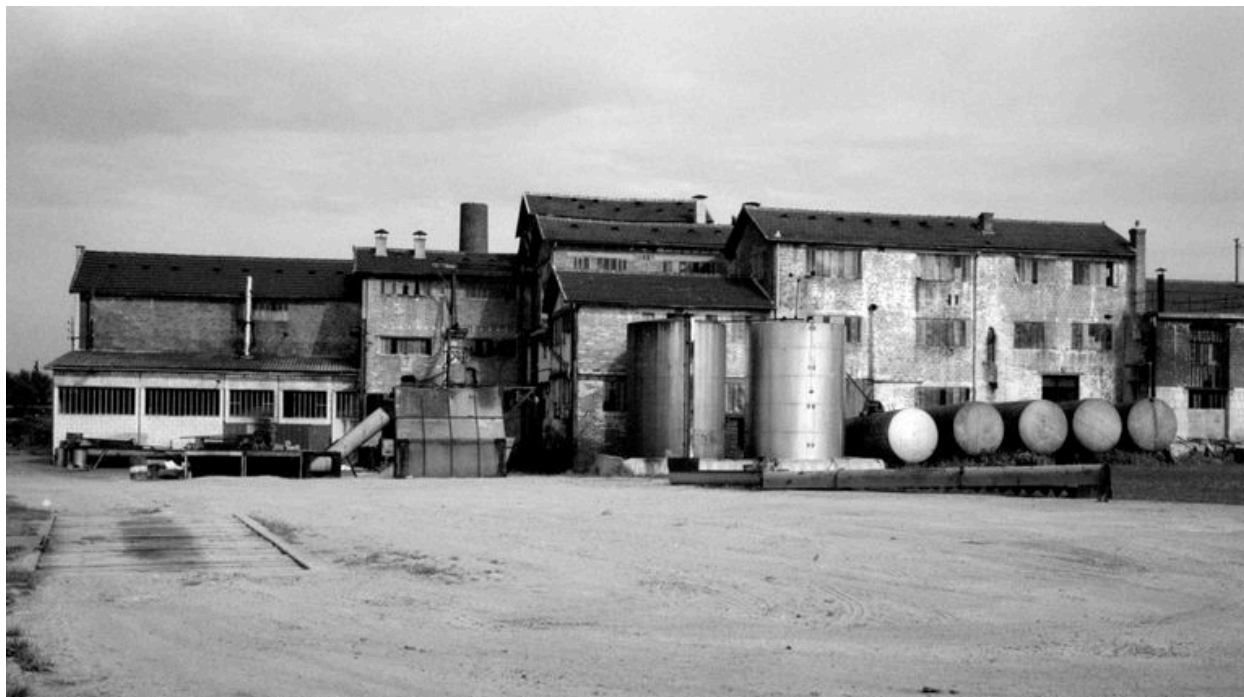
Vue générale : flanc ouest.
