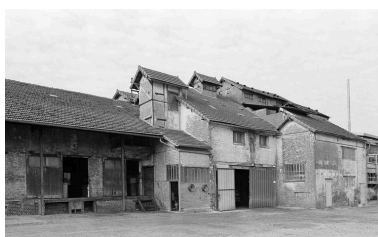
Atelier de fabrication : flanc est. Phot. Benoît Dufournier IVR22_19936002335Z
