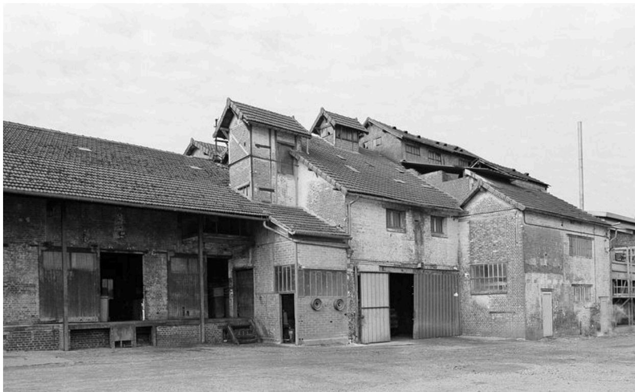
Atelier de fabrication : flanc est.
