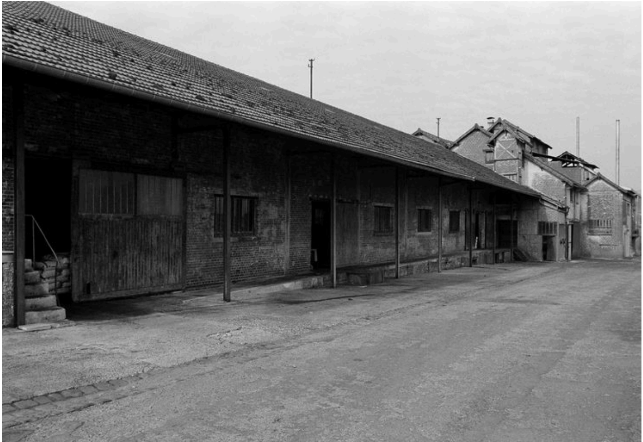
Ateliers de fabrication : flanc est.
