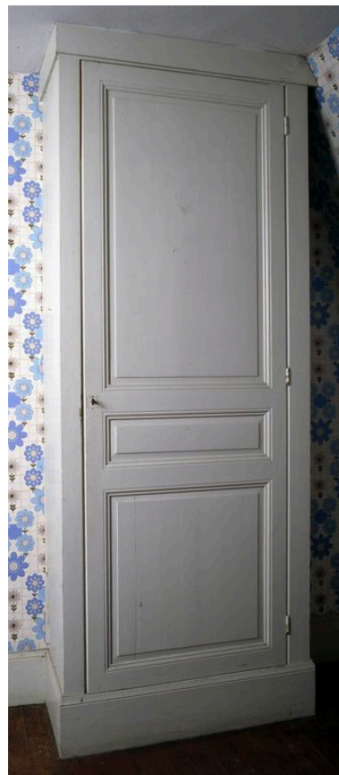
Détail d'un placard d'une chambre. Phot. Marie-Laure Monnehay-Vulliet IVR22_20058001705XA
