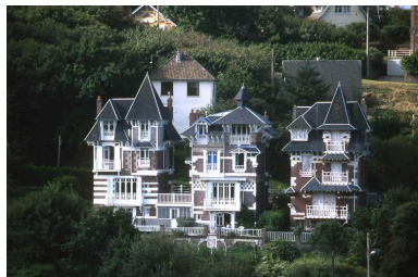
Vue générale des 'Trois chalets' avec Les Garamantes à droite. Phot. Marie-Laure Monnehay-Vulliet IVR22_20048000176ZA
