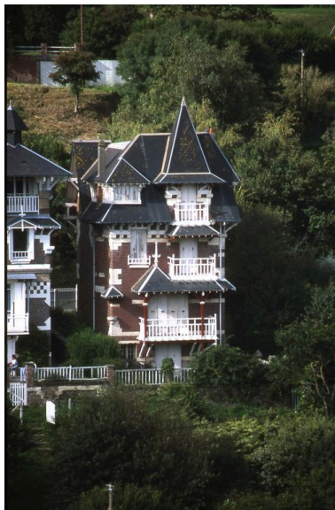
Elévation côté mer. Phot. Marie-Laure Monnehay-Vulliet IVR22_20048000181ZA
