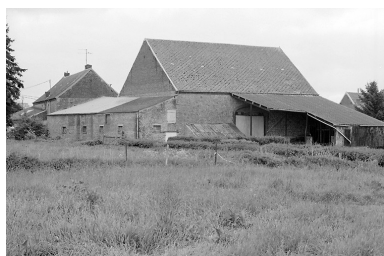
Vue de l'élévation postérieure de la grange et des étables. Phot. Pierre Thibaut IVR31_20055900619X
