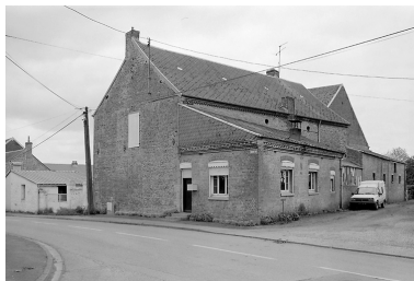
Vue de l'élévation postérieure du logis. Phot. Pierre Thibaut IVR31_20055900628X
