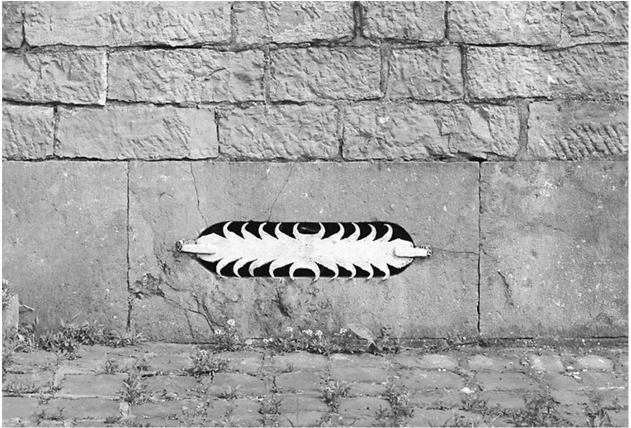
Détail d'un soubirail.
