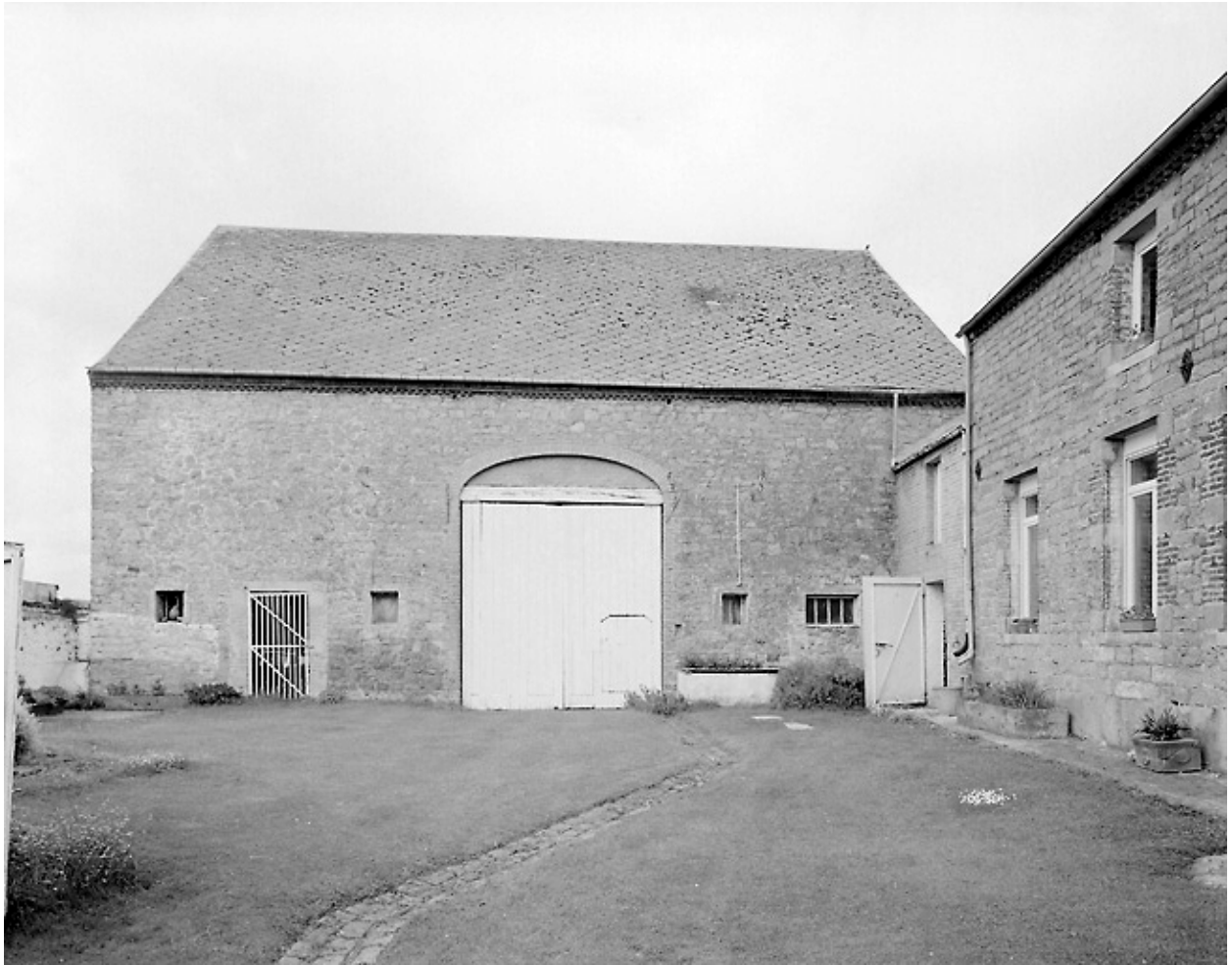
Vue générale de la grange et d'une partie du logis, depuis la cour.
