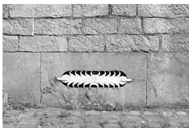
Détail d'un soupirail. Phot. Pierre Thibaut IVR31_20055900620X
