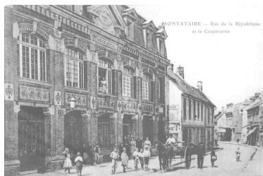
Le magasin coopératif porte la mention du siège social du syndicat des ouvriers métallurgistes de l'Oise (AC Montataire). Phot. Clarisse Lorieux IVR22_20086005121NUCAB
