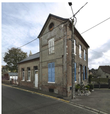
Vue générale depuis la rue des écoliers.
