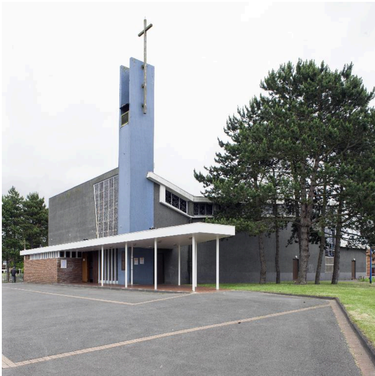
Vue de trois quart de l'élévation antérieure et du flanc droit.
