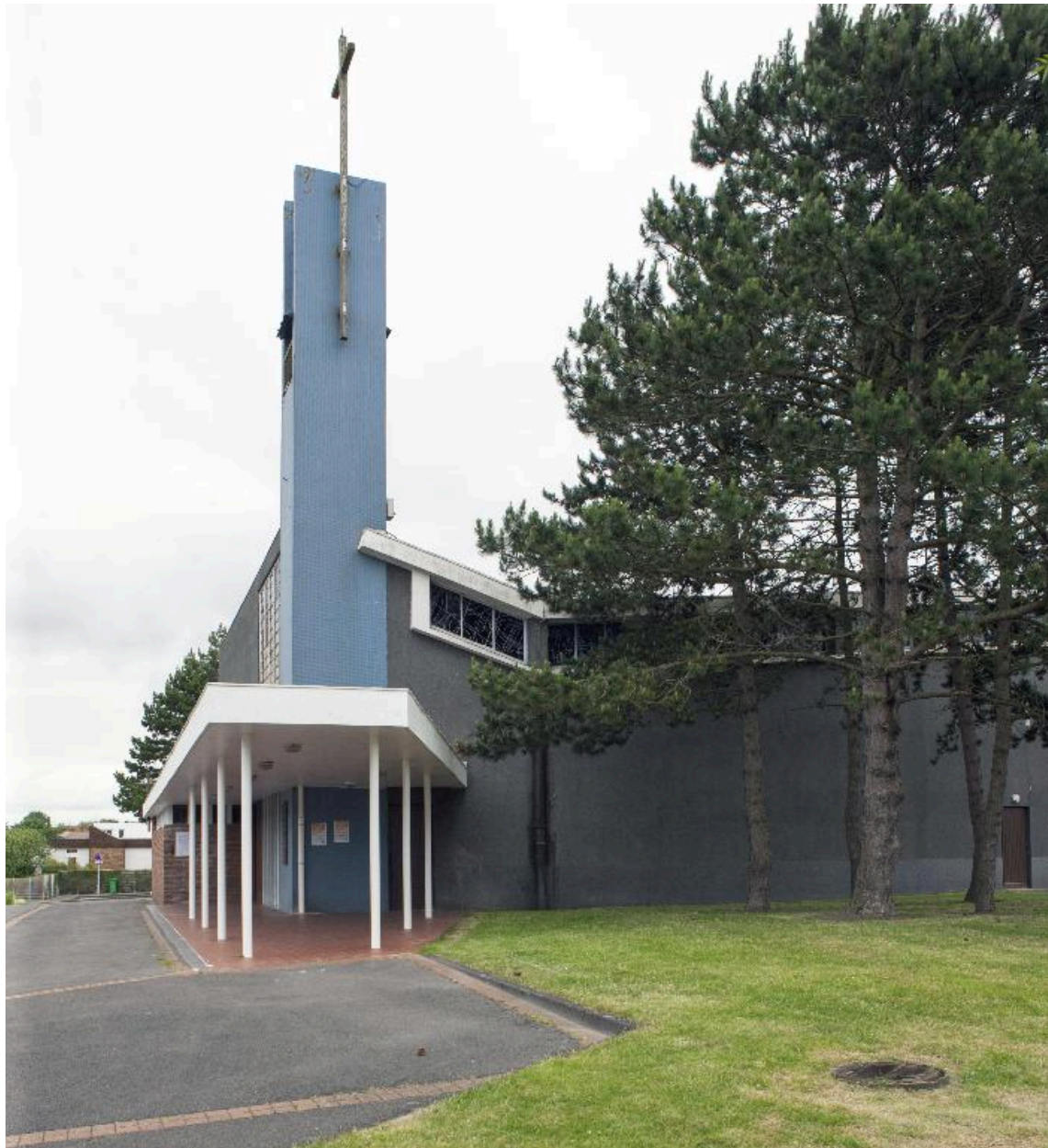
Vue de profil de la galerie devant la façade antérieure et flanc droit.
