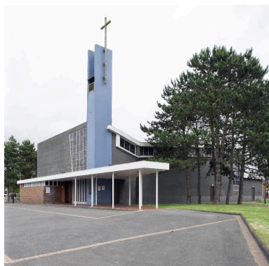
Vue de trois quart de l'élévation antérieure et du flanc droit. Phot. Pierre Thibaut IVR31_20155900548NUCA
