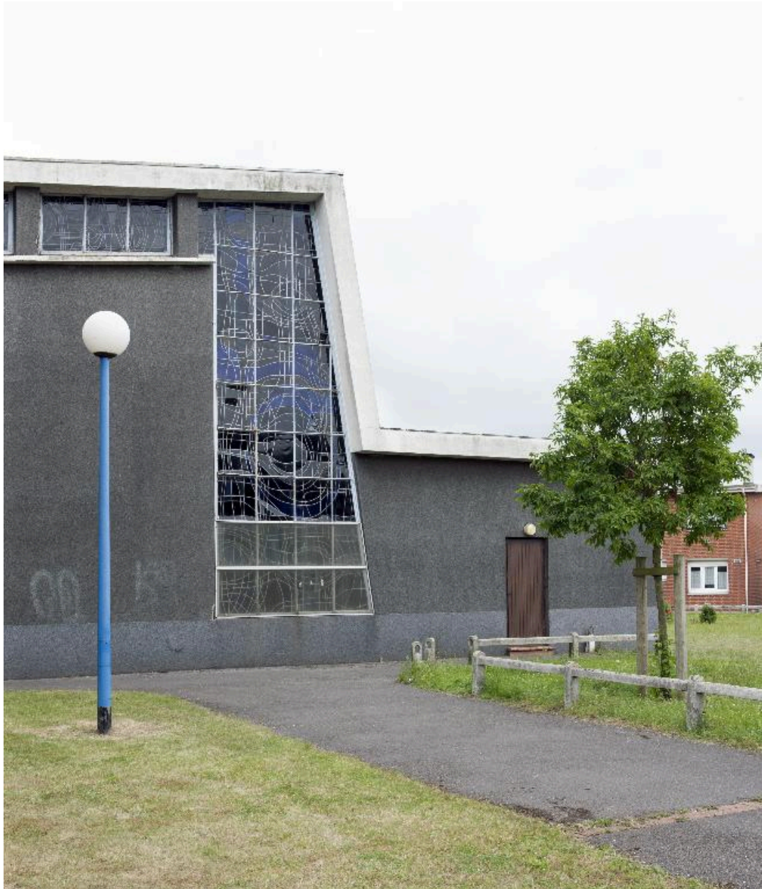
Vue extérieure de la verrière du chœur, sur le flanc droit.
