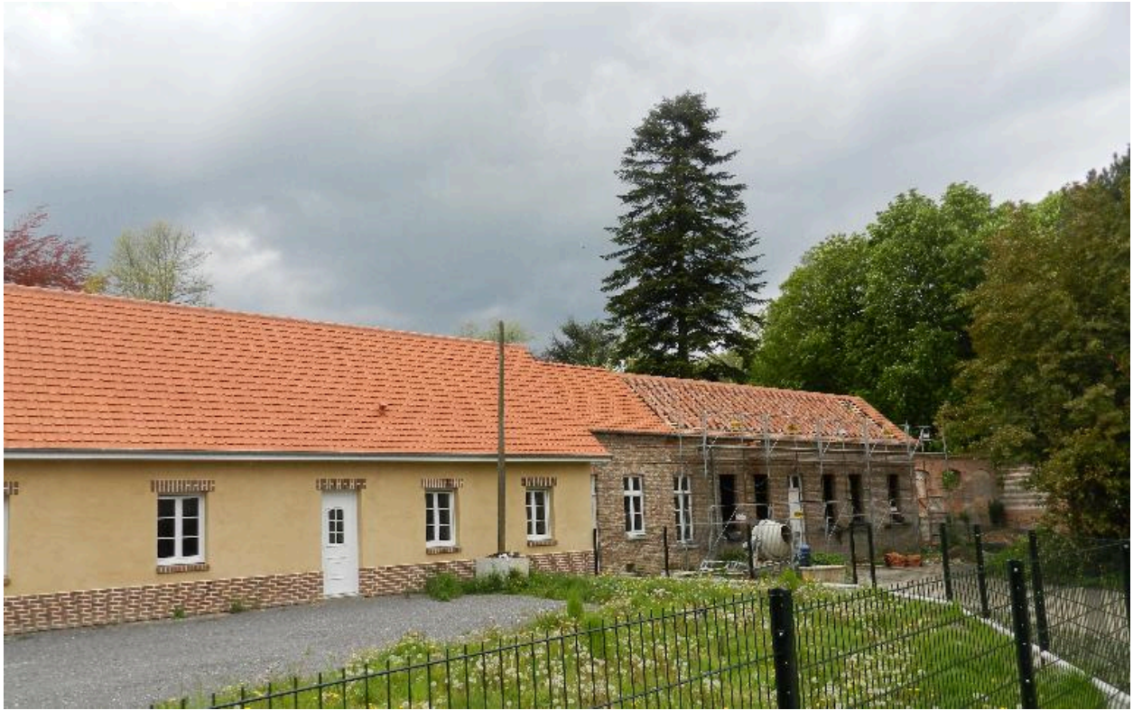
Vue de situation à refaire
