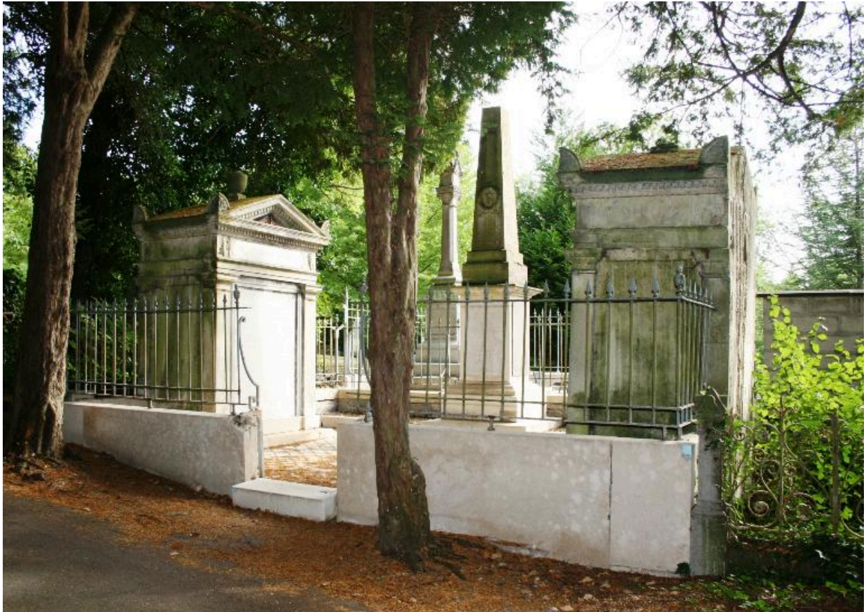
Vue générale, depuis le nord-ouest.
