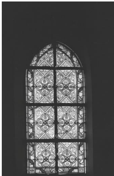
Verrière de la nef, mur nord.
