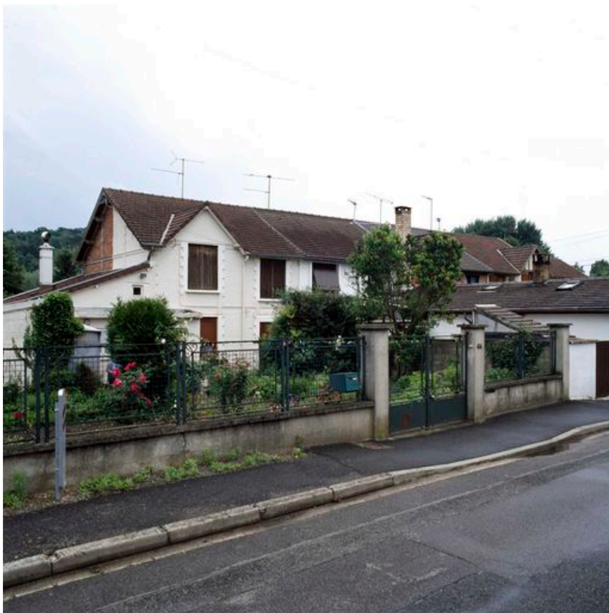
Barre de logements de la cité ouvrière Desnoyers.
