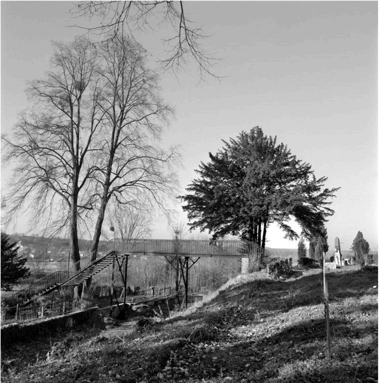
Vue de la passerelle reliant les 2 parties du jardin, et sous laquelle passait la voie ferrée.
