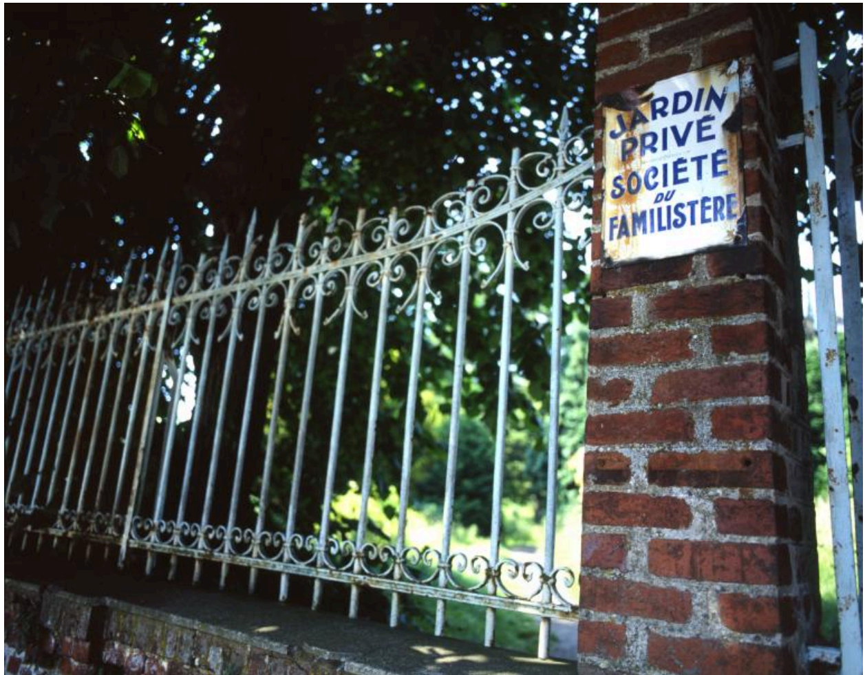
Vue d'un montant de la porte piétonne du jardin.
